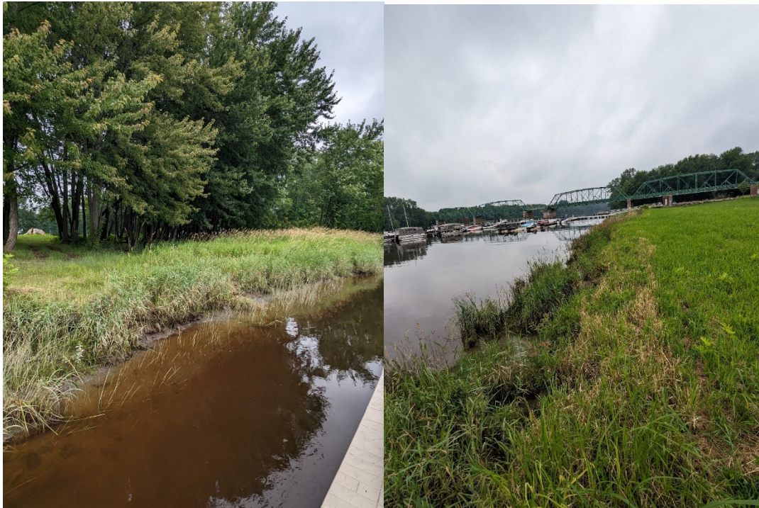
Figure 1 Microfalaise exposée actuellement à l'érosion le long de la marina
