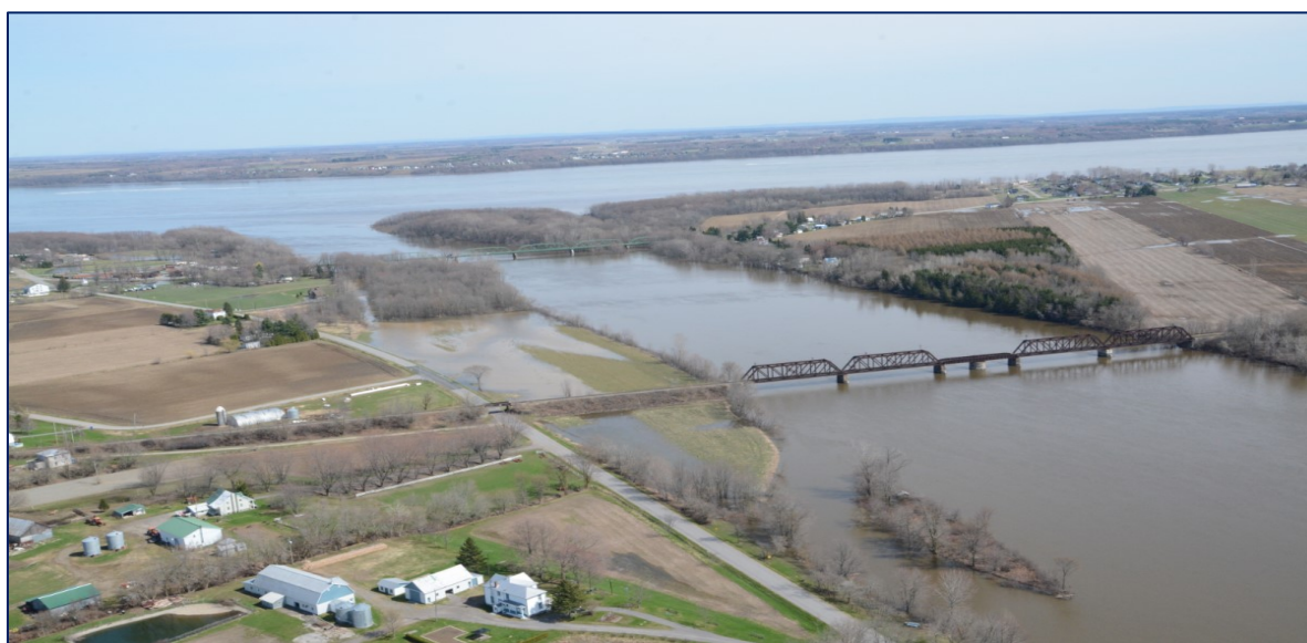
Figure 13-4 Photographies obliques présentant les inondations survenues en amont du pont P-01559 lors de la crue printanière de 2017 (4 mai 2017)
