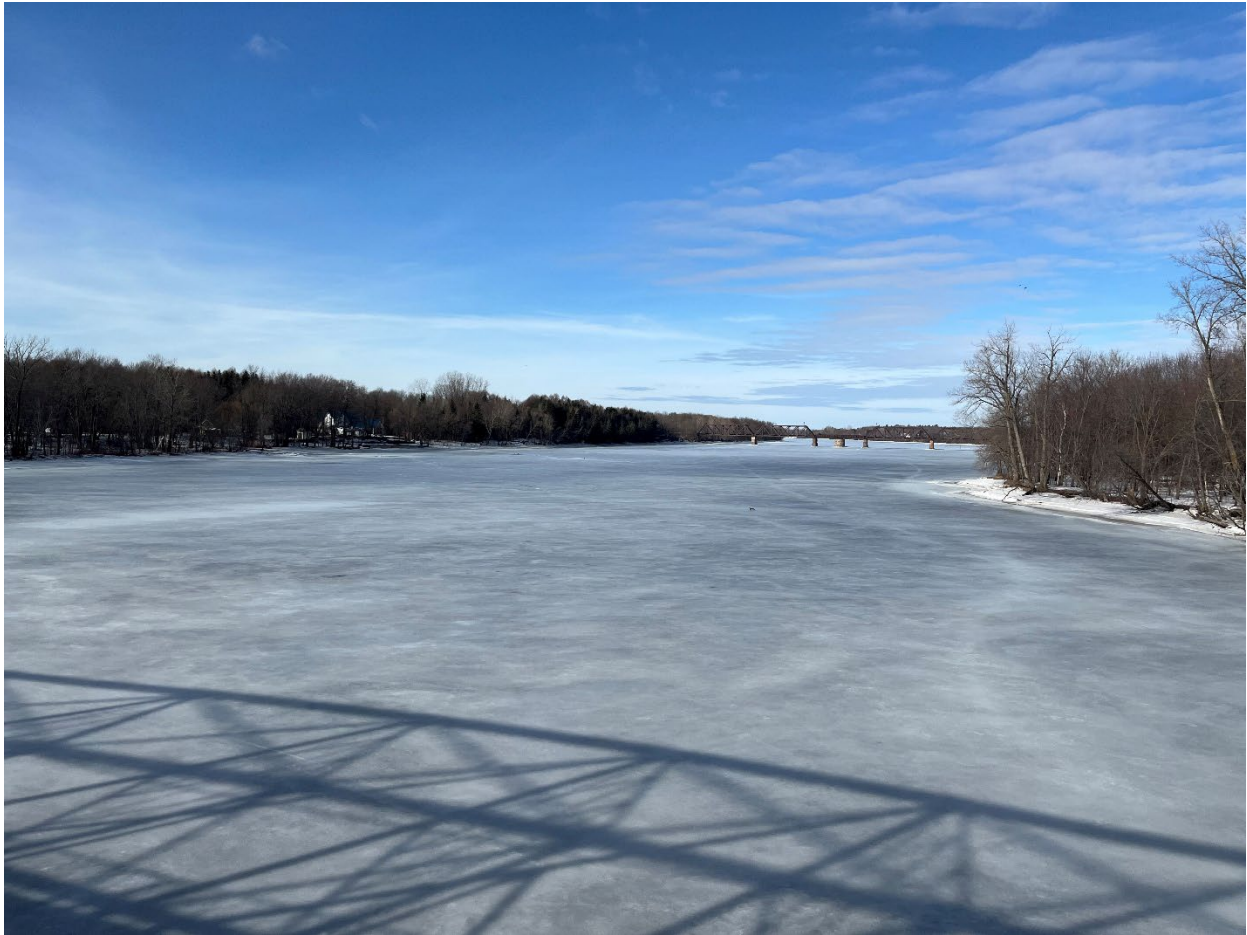
Photo 1 : Vue en amont du pont de Batiscan, prise le 3 mars 2024
