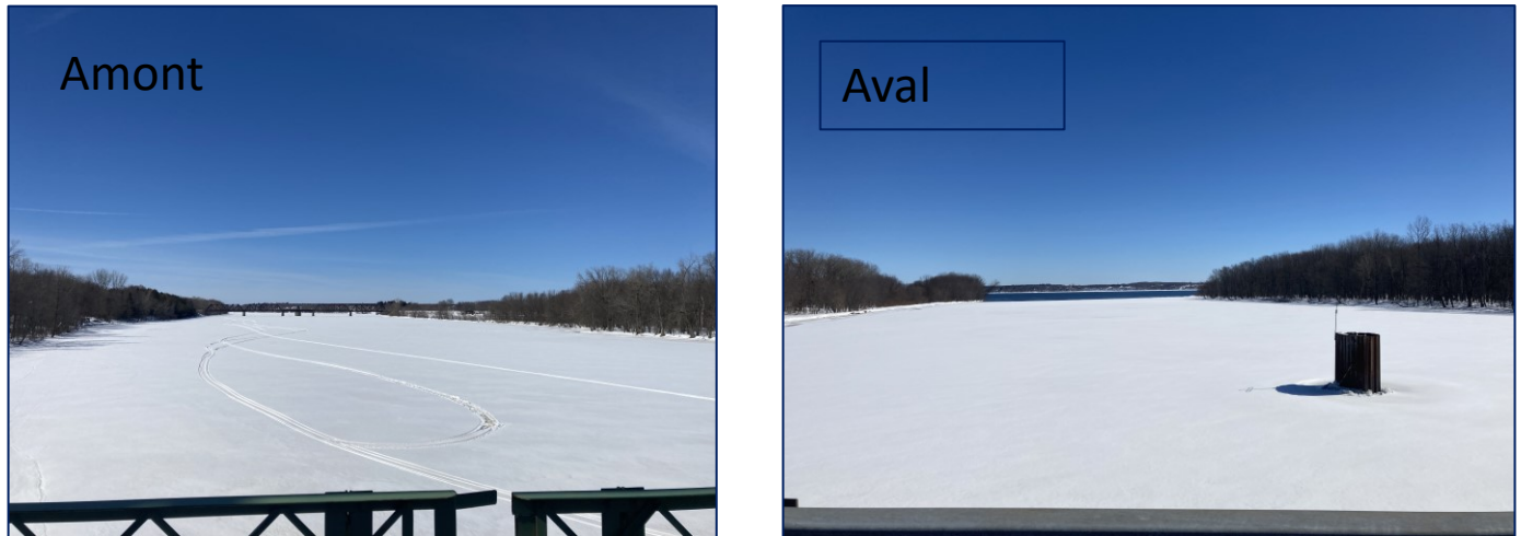
Figure 12-6 Vue sur le couvert de glace en amont et en aval de la structure (Source : C.S. 10 mars 2023)
