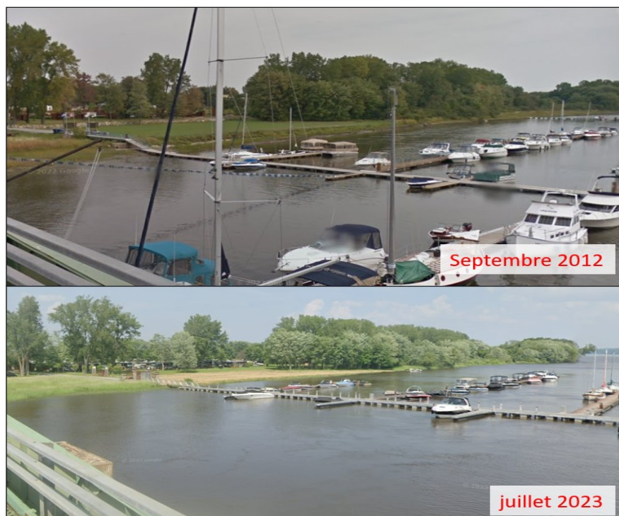
Figure 10-3 Évolution de l'érosion de la berge aval gauche entre 2012 et 2023 (Google Maps)
