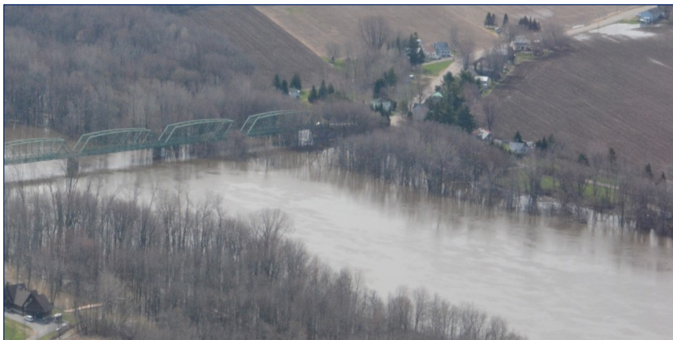
Figure 13-2 Photographies obliques présentant les inondations à l'amont droit du pont lors de la crue printanière de 2017 (4 mai 2017)
