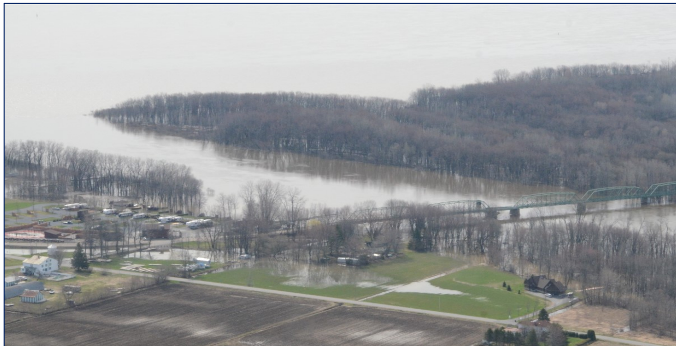
Figure 13-1 Photographies obliques présentant les inondations dans le secteur à l'étude lors de la crue printanière de 2017 (4 mai 2017)
