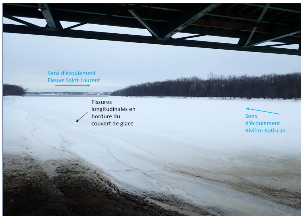
Figure 2-4 Vue sur le couvert de glace en aval de la structure (Source : DHyd, 13 mars 2023)
