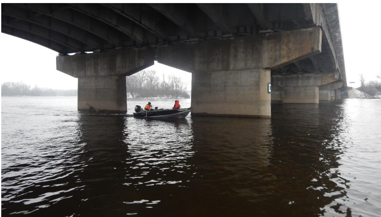
Figure 5.2 : Piles existantes dans le chenal principal
