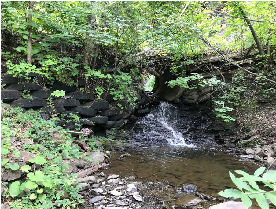
Photo 13. Grande Rivière, ponceau, fin section 2
