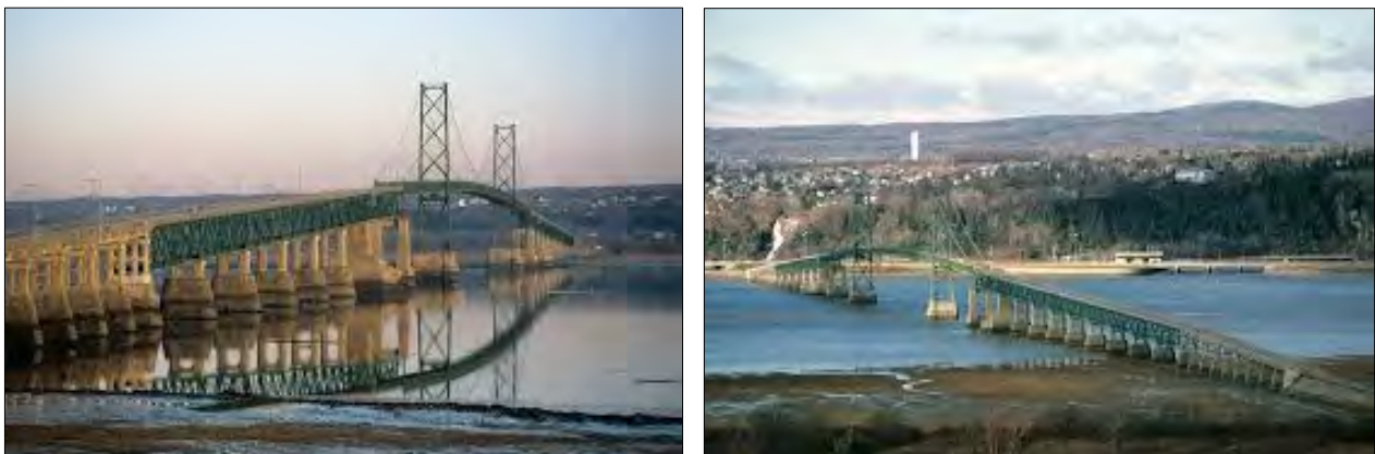
Photo 15 Pont de l'Île-d'Orléans, vue vers le sud et vue vers le nord (Transports.gouv.qc.ca)
