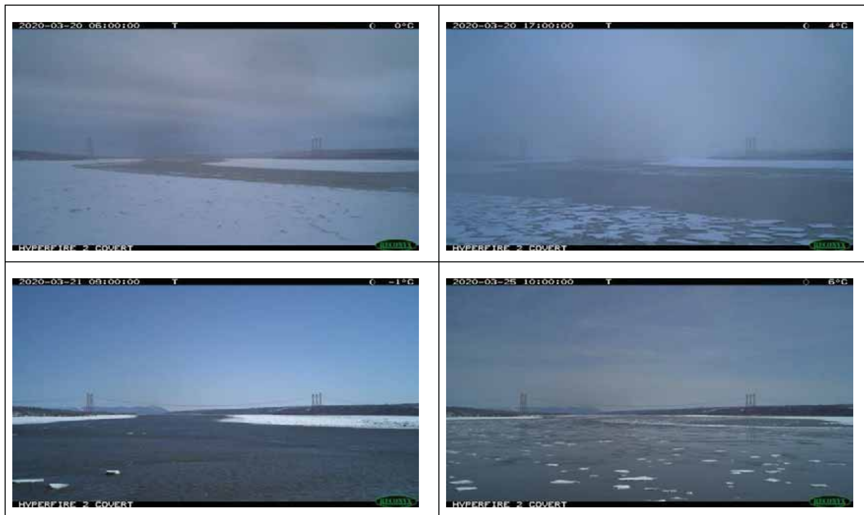
Figure B-11 Couvert de glace du côté amont, au centre du chenal, en mars 2020
