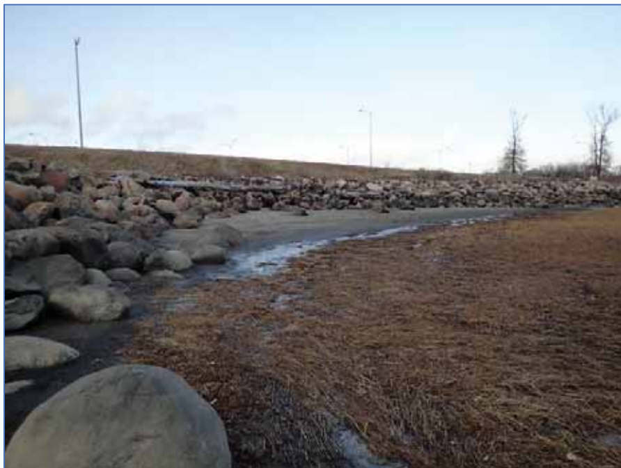
Figure 2-8 Légère accumulation de sédiments, rive nord, en aval du pont à l'étude
