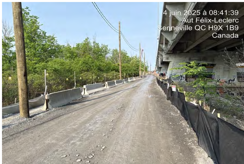
Photo 1- Barrières d'exclusion (type géotextile sur piquets de bois) sur la rive sud de l'Île Girwood
