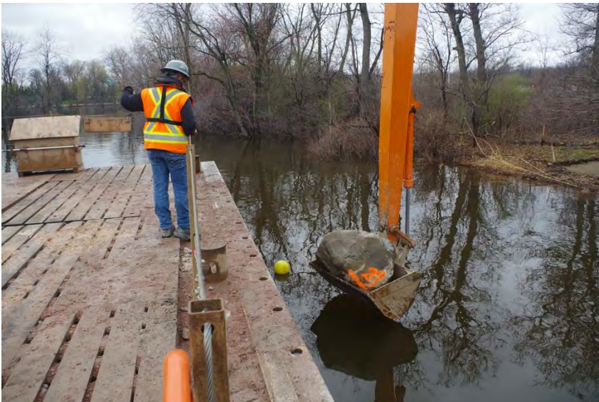
Photo 6- Mise à l'eau d'une roche émergente près du site de pont 4 à Vaudreuil
