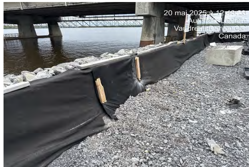
Photo 3- Barrières d'exclusion (type glissières avec géotextile) sur la jetée 1C de l'Île-aux-Tourtes
