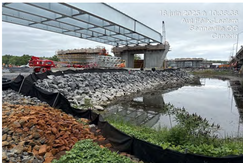
Photo 2- Barrières d'exclusion (type géotextile sur piquets de bois) à la jetée 3 de l'Île Girwood
