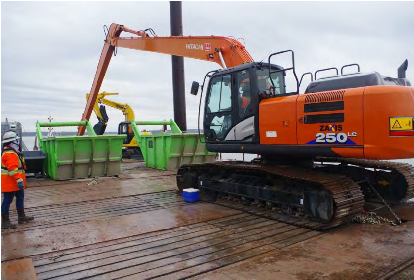
Photo 5- Barge et pelle mécanique utilisées pour l'aménagement de roches émergentes à tortues
