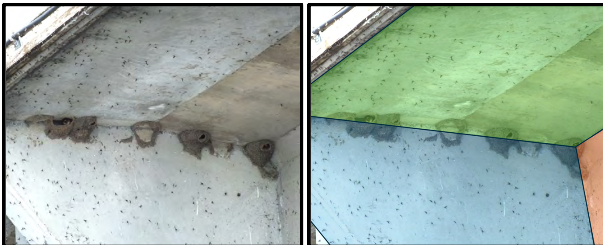
Figure 6. Position de nids d'hirondelles à front blanc orientés vers l'est (Senneville) sur la face externe du côté sud (aval) du PIAT par rapport au diaphragme (bleu), au tablier (vert) et à la poutre 1 (orange)
