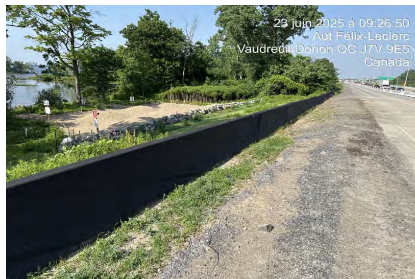
Photo 4- Barrières d'exclusion (type glissières avec géotextile) près du site de pont 4 à Vaudreuil
