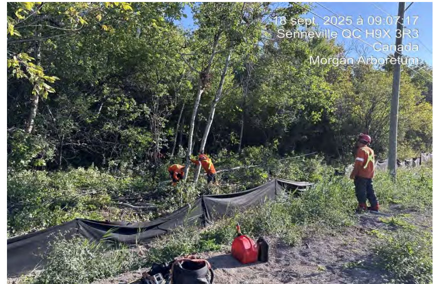
Photo 7- Déboisement du milieu humide MH97 dans la forêt de Senneville le 18 septembre 2025
