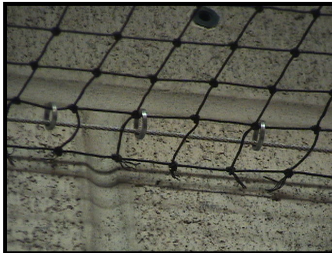
Figure 7. Exemple de pose d'un système de filets avec câbles et anneaux
