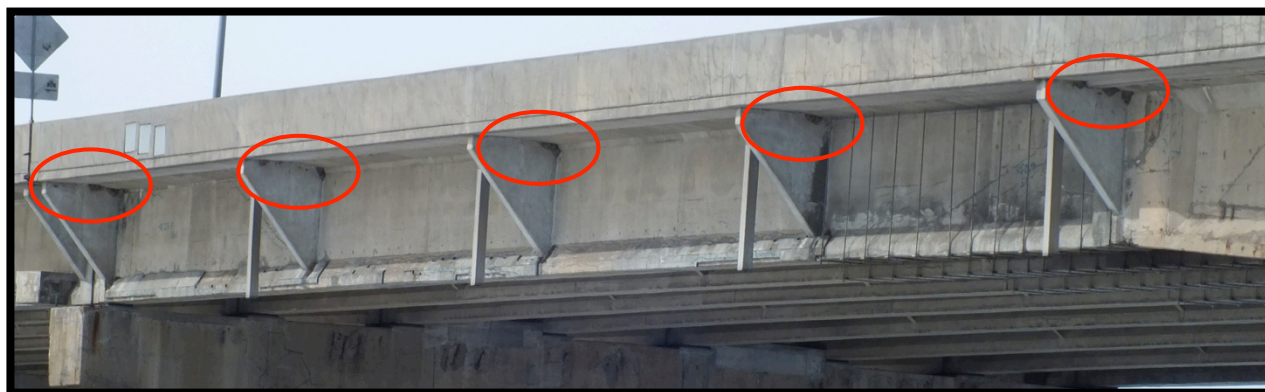
Figure 2. Exemple de nids d'hirondelle au niveau des corbeaux de la poutre de rive au pont de l'Île-aux-Tourtes en 2014
