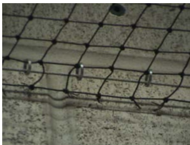
Figure 9. Exemple de pose d'un système de filets avec câbles et anneaux (MTQ, 2014)
