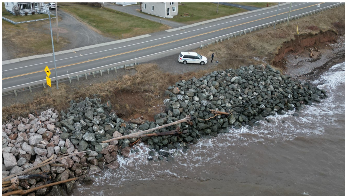
Figure 7-1 Photographie de décembre 2023. Progression de la zone endommagée entre les deux empierrements.
