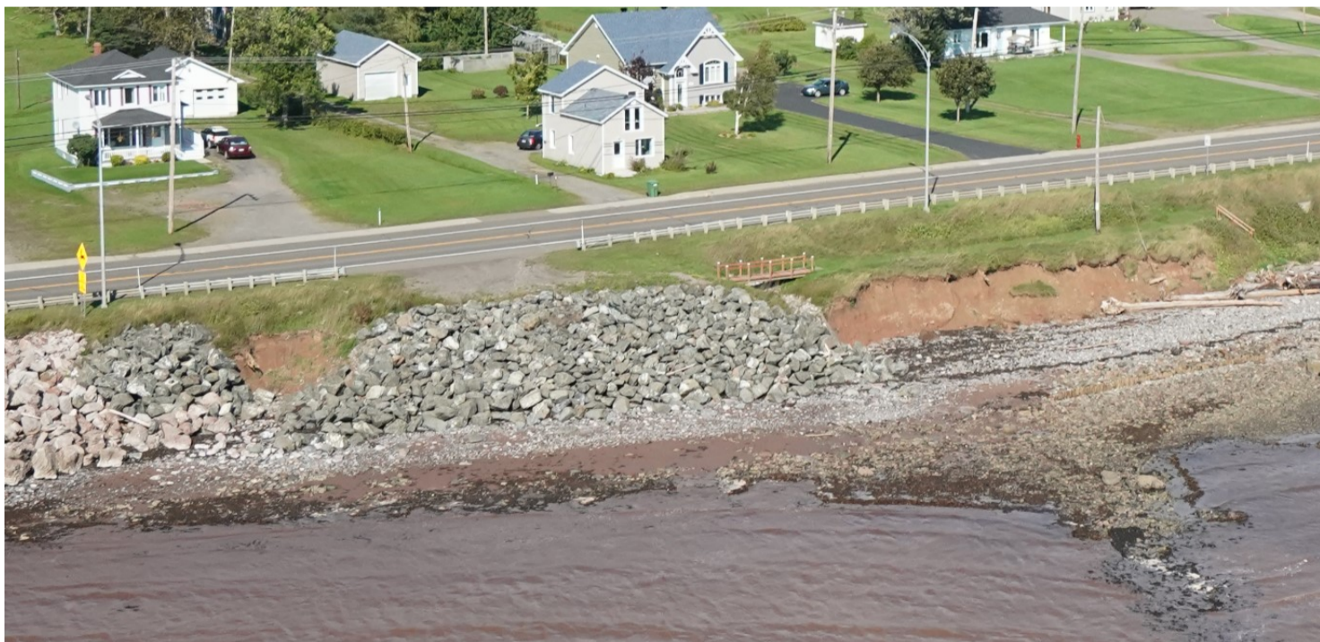
Figure 5-1 Photographie oblique de 2021. Érosion qui se propage vers l’est. Réparation de la zone érodée en 2017. Brèche dans l’empierrement entre la nouvelle protection et l’ancienne. Source : LDGIZC
