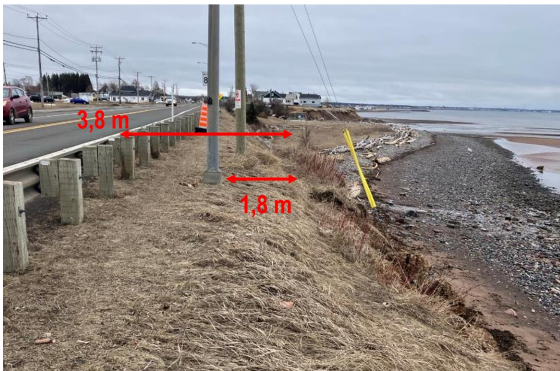
Figure 5 – Marge de recul entre la glissière de sécurité et le haut du talus de la côte (source : MTMD, avril 2024)
