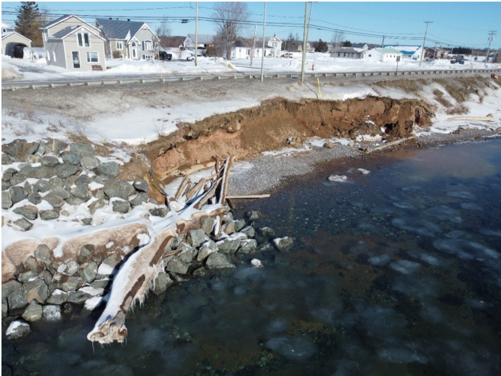
Figure 6-1 Photographie de 2024. L'érosion progresse encore dans le talus. L'ancrage du hauban qui soutient le poteau d'utilité publique est complètement dénudé.
