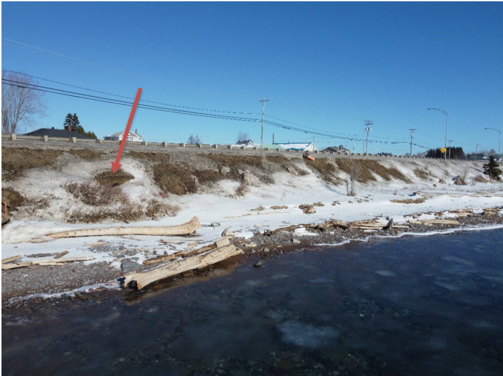
Figure 6-2 Photographie de 2024. Il n'y a pas de signe de progression de l'érosion à l'est du ponceau (indiqué par la flèche).
