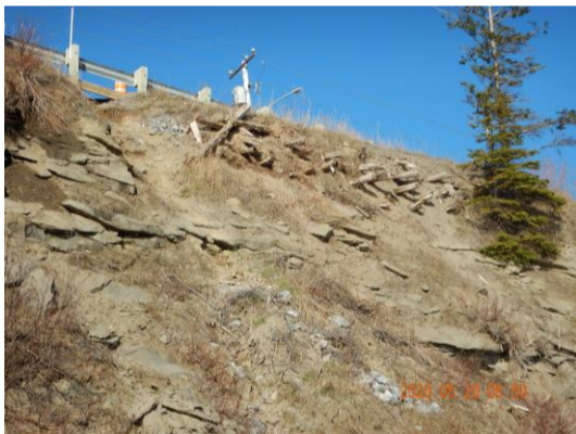
Figure 10. Vue du secteur renforcé par des poutres de bois adjacent au glissement.
