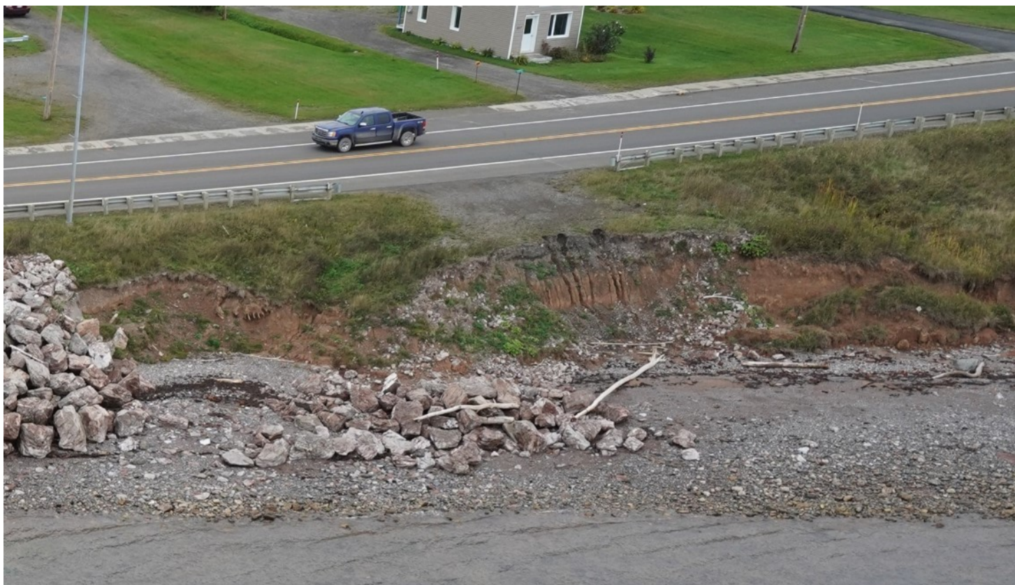
Figure 4-3 Photographie oblique de 2017, décrochements plus importants et érosion apparente. Enrochement de la côte affaissé. Source LDGIZC
