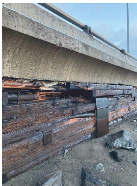
Figure 9 - Altération du mur en surface, créant des trous dans le parement (source : MTMD)
