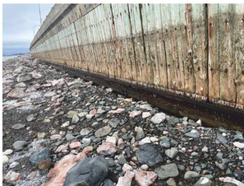
Figure 15 - Abaissement du profil de plage devant le mur (ch. 8+542), le rendant très vulnérable à l'affouillement, 11 janvier 2024 (source : MTMD)
