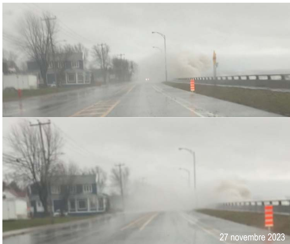
Figure 5 - Franchissement de vagues lors d'un épisode de tempête le 27 novembre 2023 au droit du secteur visé par les travaux de recharge granulaire (source : MTMD)
