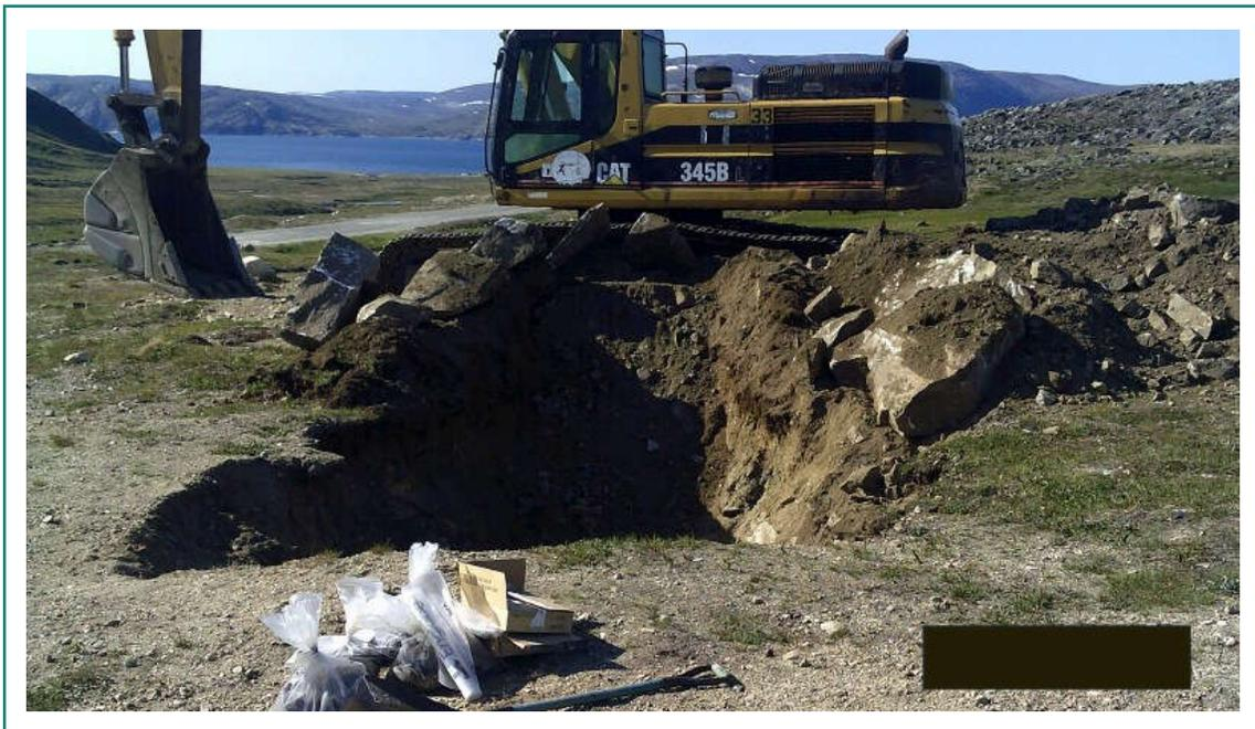
Photo 6 : Vue de l'emplacement et de l'excavation du puits d'exploration PU-13-22.
