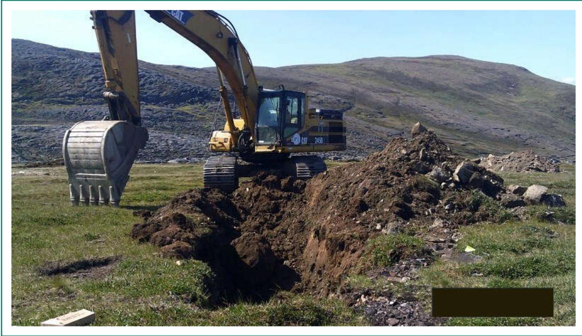
Photo 3 : Vue de l'emplacement et de l'excavation du puits d'exploration PU-07-22.
