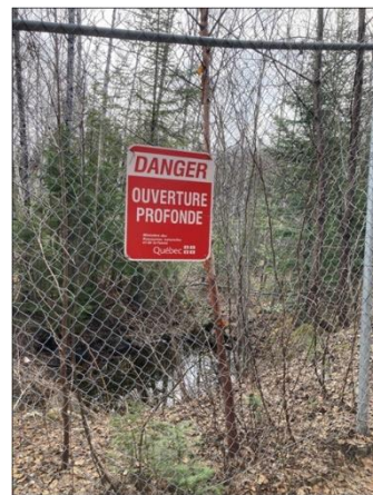
Photo 18 Site C – Enseigne décrochée (après)
