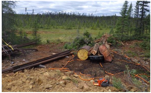
Photo 6 Travaux de nettoyage
