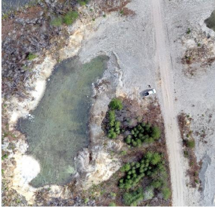
Photo 19 Secteur ouest du banc d'emprunt (secteur A)
