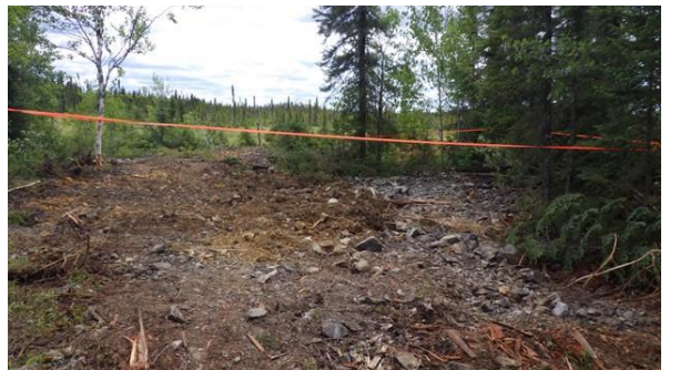
Photo 8 Site après les travaux de nettoyage
