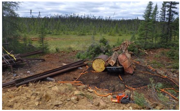
Photo 6 Travaux de nettoyage
