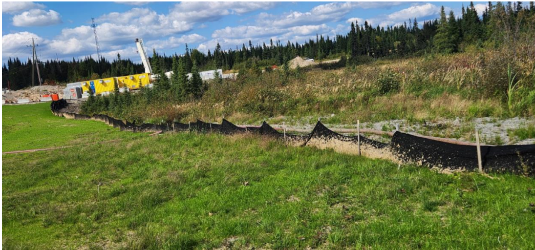
Photos 4, 5 et 6 Préparation terrain et hydroensemencement autour du bassin D
