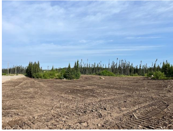
Photos 2 et 3 Reprofilage du terrain pour retour aux conditions initiales
