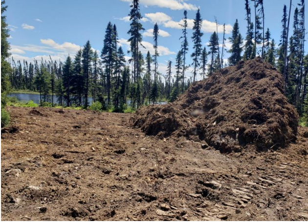
Photo 1 Apport de mort terrain pour étalement sur le terrain
