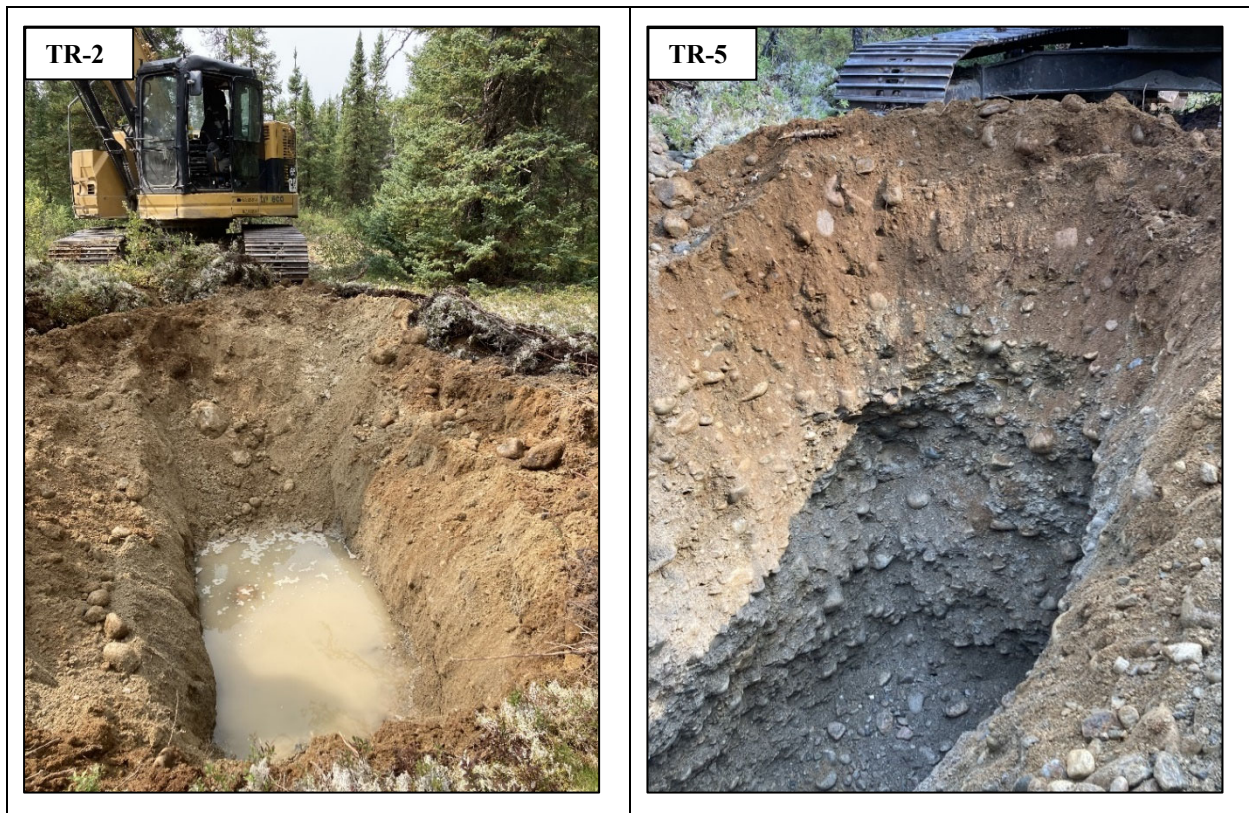
Figure 3 Banc B-4 : Proportion plus faible de matériaux grossiers dans la tranchée TR-2 (à l'est) que dans la tranchée TR-5 (à l'ouest).
