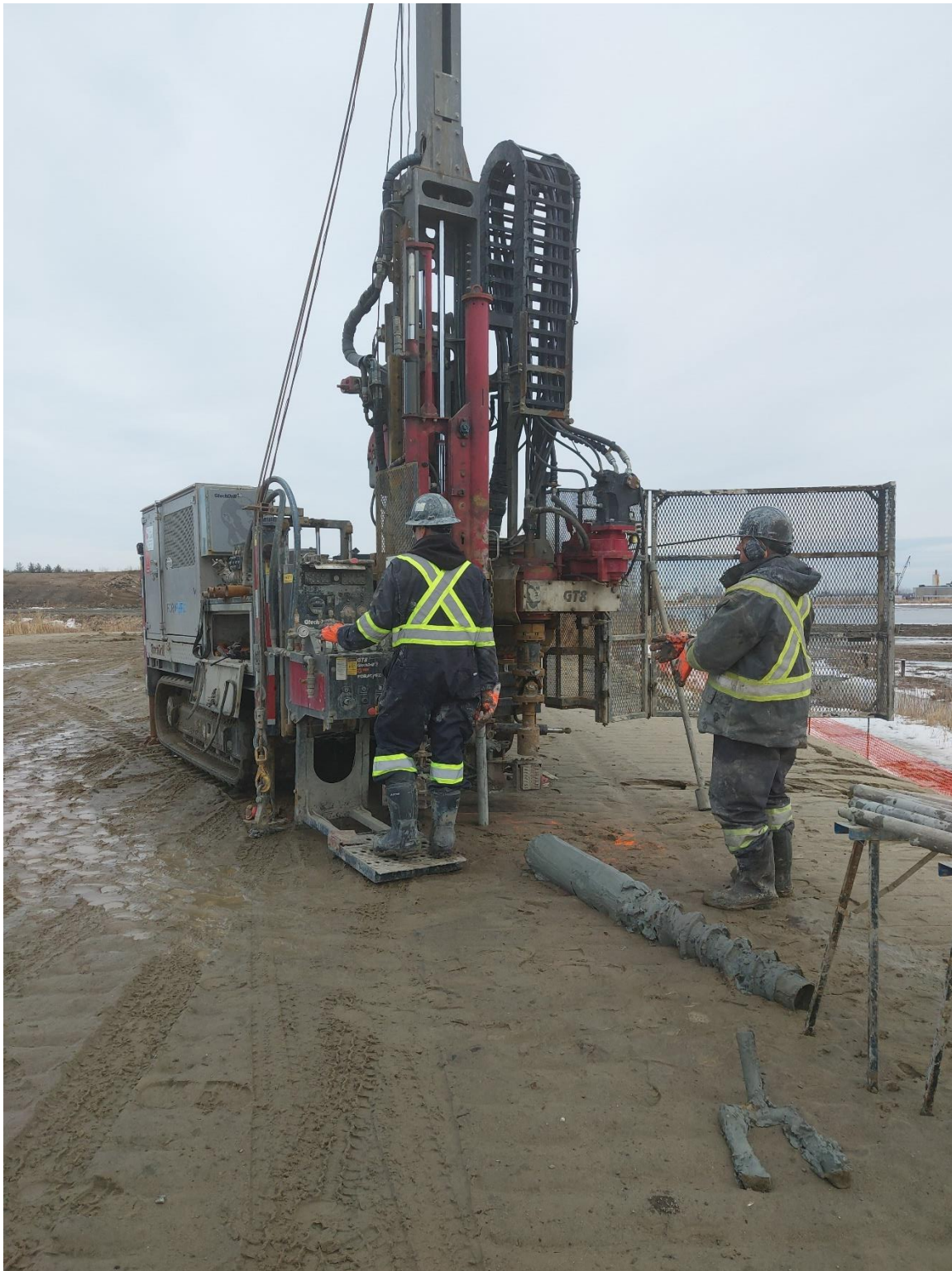
Photo 1 : Travaux de forage - 26F03
