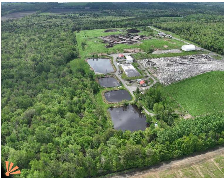
Vue aérienne par drone en 2024 à partir du nord-est vers le sud-ouest
