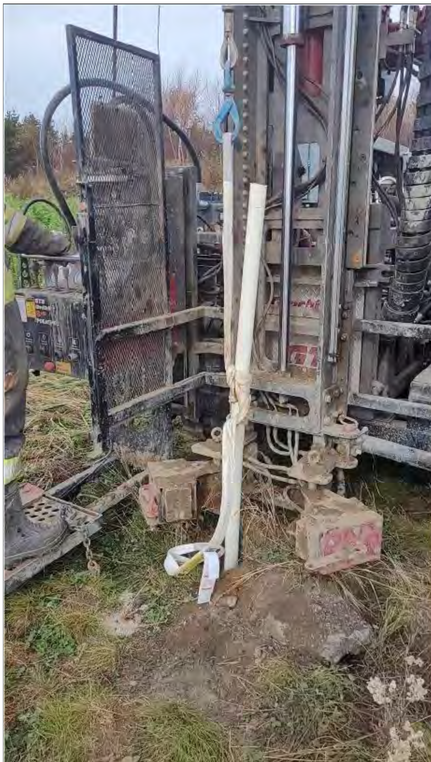
Photo 10 : Démantèlement d'un puits d'observation – enlèvement du tuyau PVC
