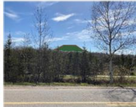
VUE DU # 282 ROUTE PIERRE NEVEJ VERS LA ZONE B D'AGRANDISSEMENT (APRES TRAVAUX)
