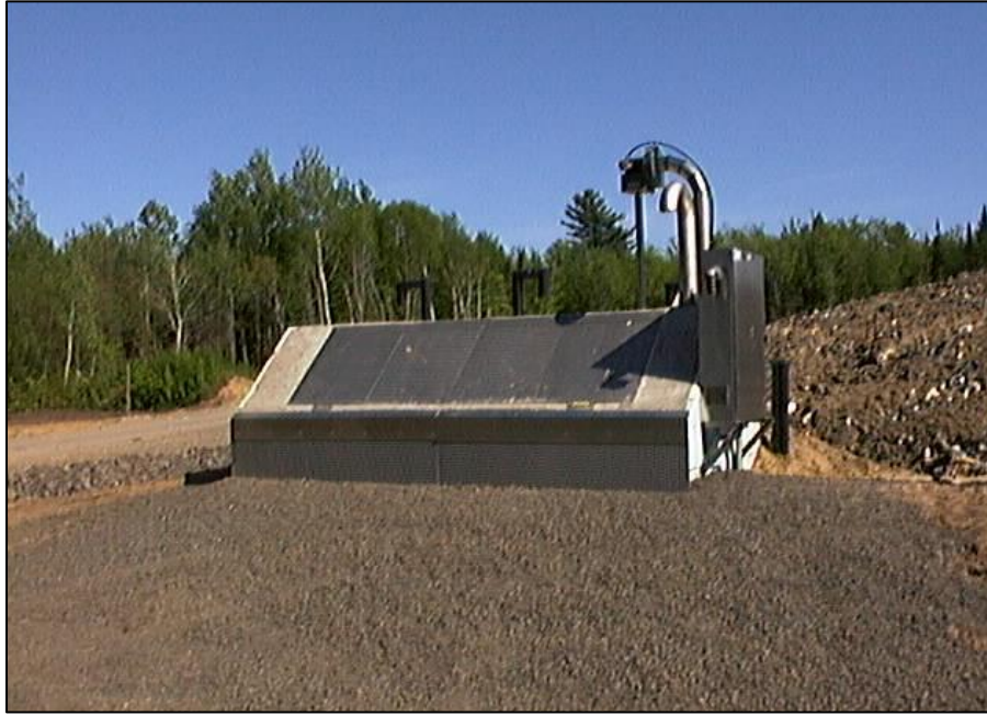
Photo 8. Station de pompage du lixiviat (typique)
