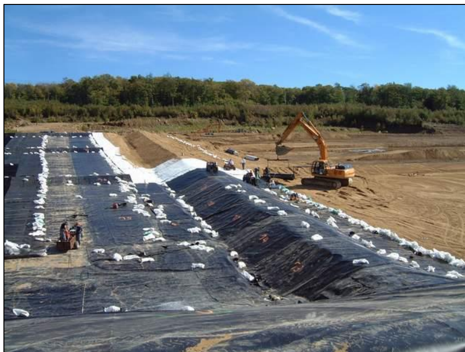
Photo 4. Aménagement du système d'imperméabilisation en fond de cellule
