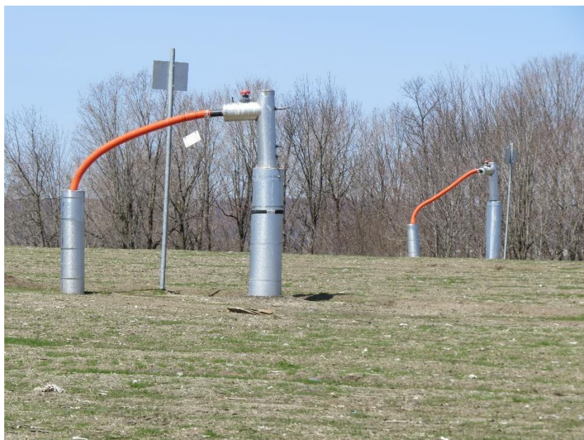
Photo 10. Puits typiques d'extraction des biogaz
