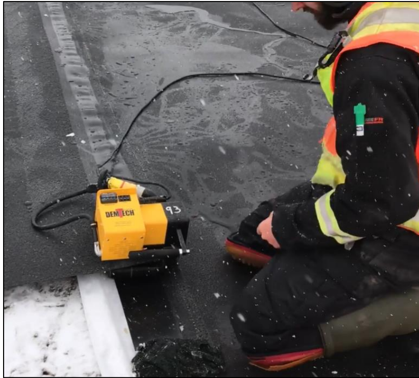
Photo 6. Mise en place et soudure des géomembranes
