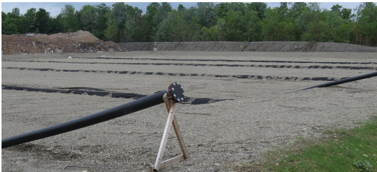
Photo 7. Couche de pierre concassée du réseau de collecte primaire
