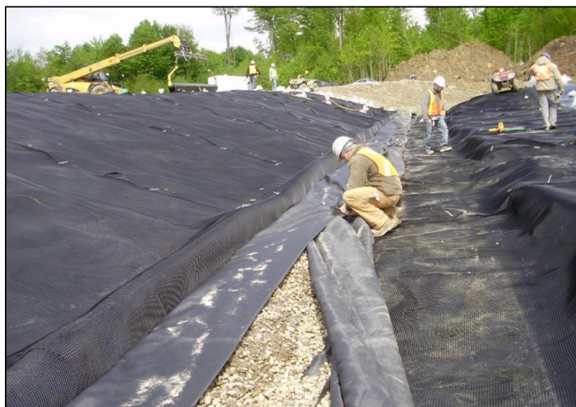
Photo 5. Mise en place et soudure des géomembranes
