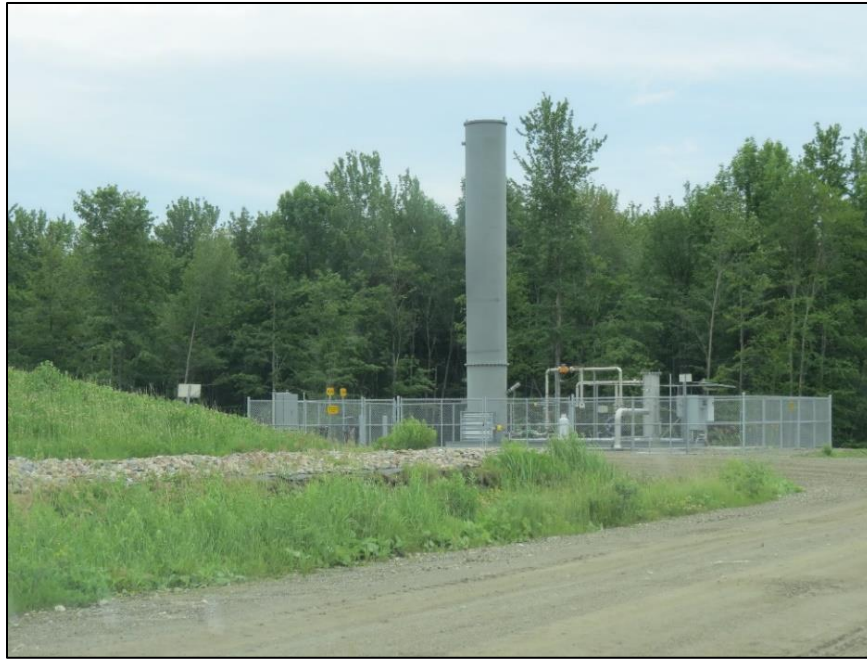
Photo 11. Torchère à flamme invisible en place au site de Valoris
