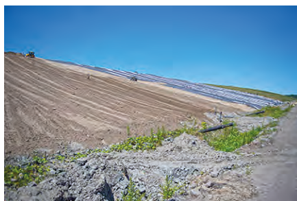
Recouvrement d'une couche de sable drainant
