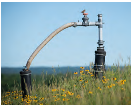
Puits vertical de captage des biogaz sur l'ancien site
