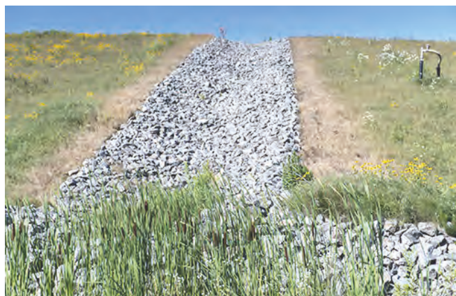
Fossé de drainage des eaux pluviales
