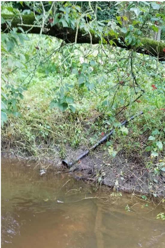
Photo QC-27-2 Tuyau de drainage se déversant dans le ruisseau aux Castors
