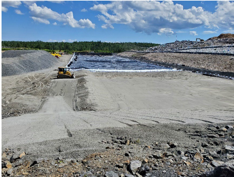
Photo 4-1 : Mise en place de la barrière imperméable
