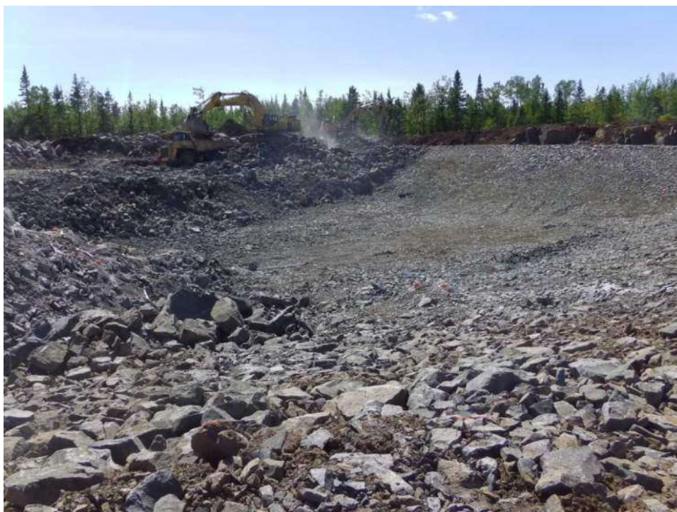
Photo no 7 – Bassin d'accumulation des lixiviats en cours de profilage avec fond implanté à l'élévation 190,7m . Les forages et puits d'observations d'avant-projet dans ce secteur (F-7-12, F-8-12 et PO-8-11) avaient pourtant identifié le niveau des eaux souterraines à des élévations variant entre 193,4m et 195,8m.
