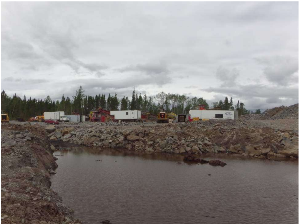
Photo no 4 – Excavation et remblayage de la partie de la cellule no. 3 recoupée par la dépression profonde à l'été 2014.
