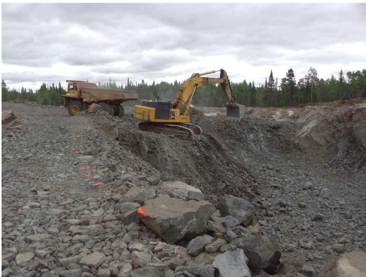
Photo no 6 – Aménagement du bassin d'accumulation des lixiviats en déblai dans le roc sur près de 7 mètres d'épaisseur en moyenne au cours de l'été 2014.
