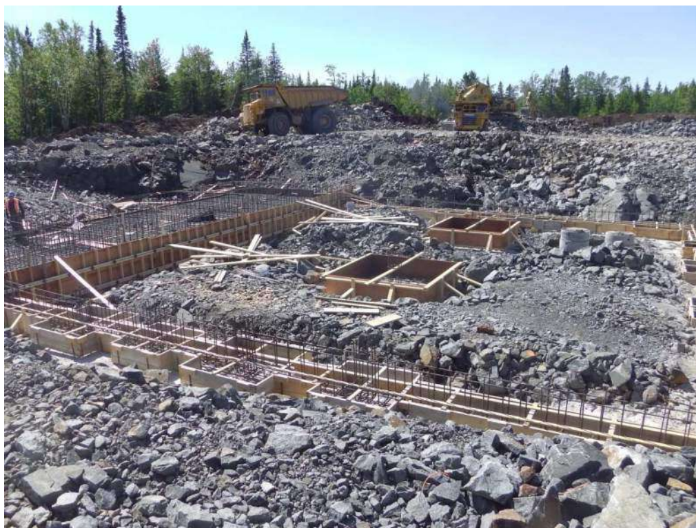
Photo no 8 – Fondations de l'usine de traitement des lixiviats se trouvant à l'élévation 192,59m. A proximité de ce bâtiment se trouvait le forage F-7-12 dont le niveau de la nappe avait été établi à 195,8m en avant-projet en 2012.
