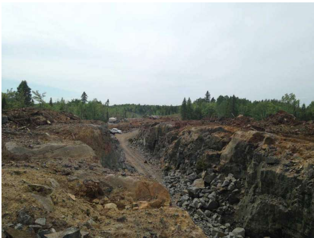
Photo no 1 – Visée ouest en direction des cellules à partir de l'emplacement de la balance (côté sud chemin d'accès). Importants déblais de roc, présence occasionnelles de nappes perchées d'étendue locale en surface.
