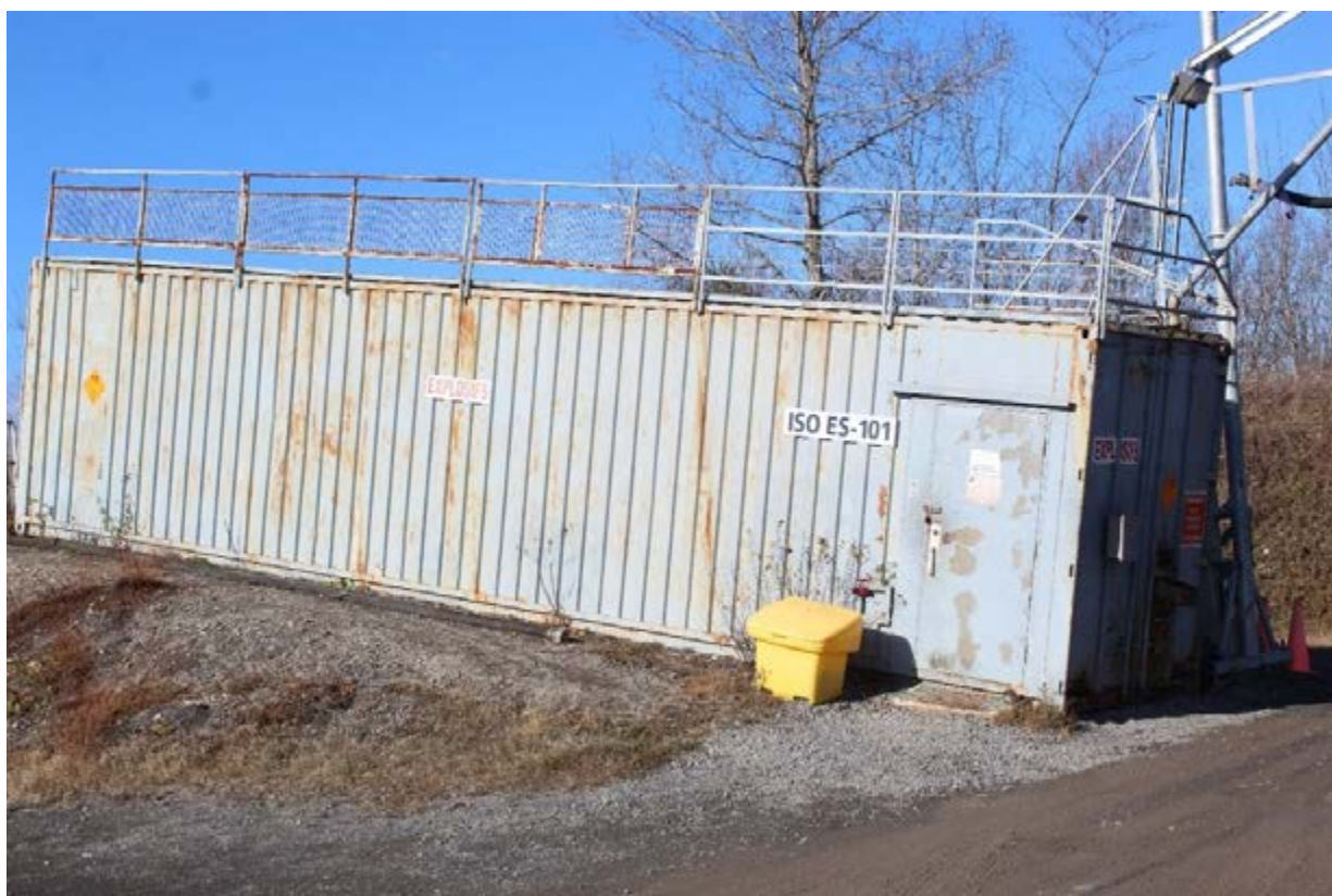
Figure 4 Conteneur-citerne dédié à l'entreposage d'explosif liquide
