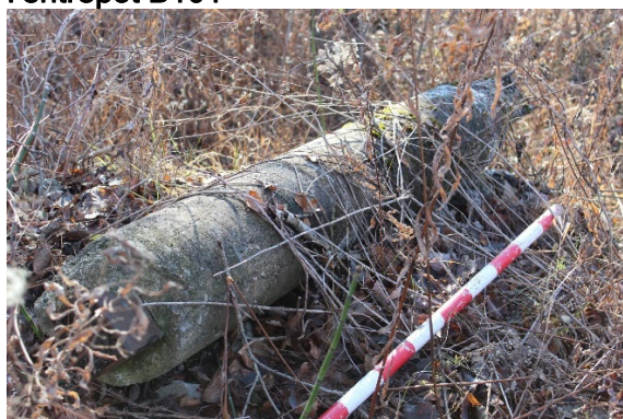
Pieu « zonotube » à proximité de l'entrepôt B101
