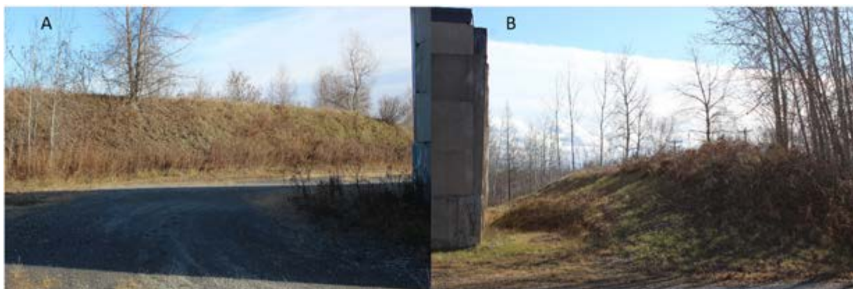
Figure 3 Exemples des deux types de buttes antichocs aménagées au nord (A) et au sud-est (B) des « bunkers »
