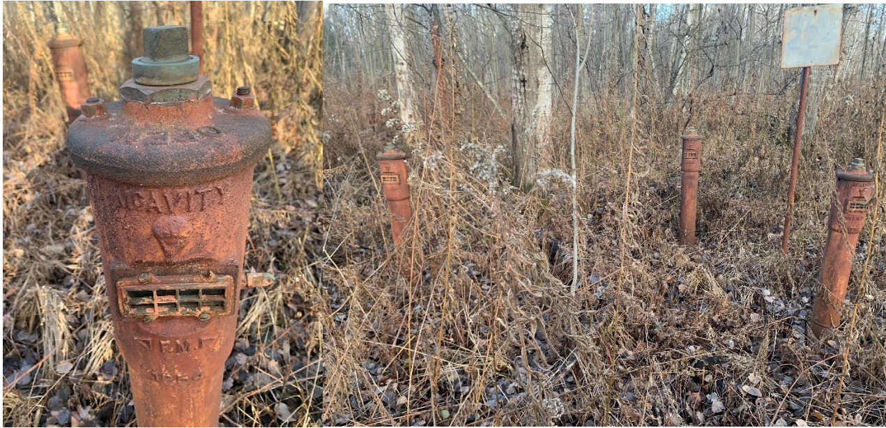
Figure 32 : Exemple de borne-fontaine de marque McAvity trouvé sur le site portant la marque d'année de fabrication « 1954 »
