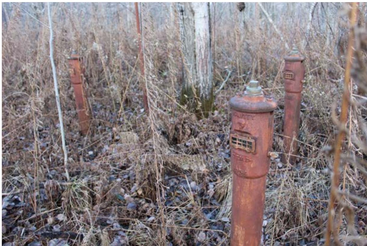
Figure 8 Trois vannes à colonne indicatrice de 1954 « McAvity » à l'ouest de C102
