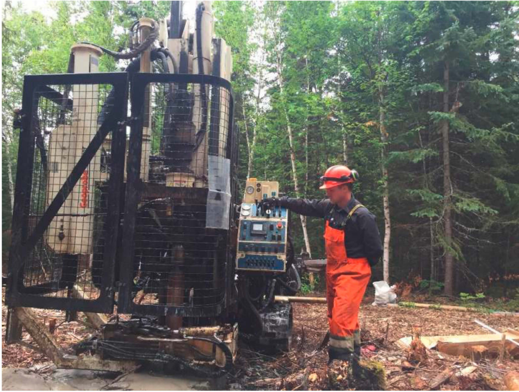
Photo 4 : Mise en place de la crépine et du tubage du piézomètre
