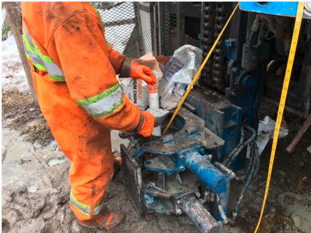
Photo 48 : Aménagement du piézomètre PZ-07R
