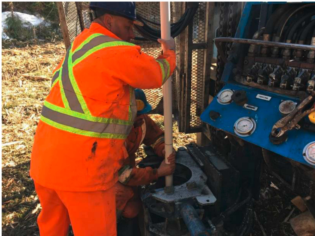
Photo 52 : Aménagement du piézomètre PZ-16R
