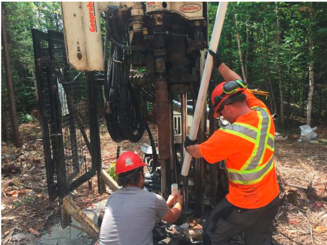
Photo 4 : Mise en place de la crépine et du tubage du piézomètre
