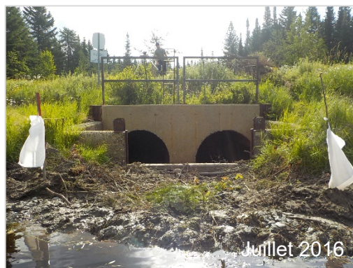
Présence de débris à la structure
