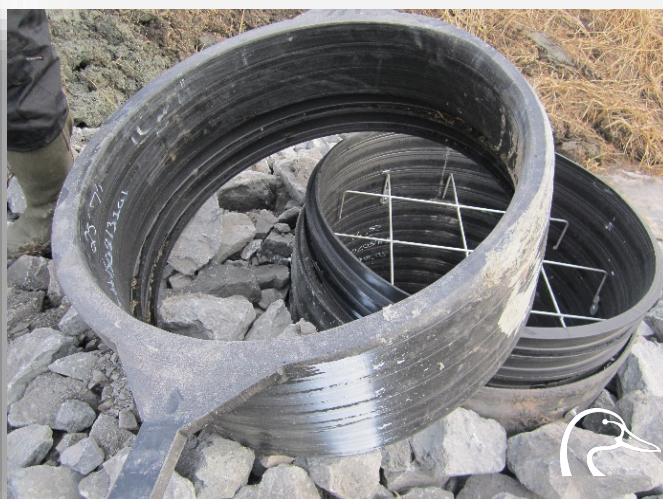
Côté aval de la structure et bague d'ajustement du rehaussement du niveau d'eau
