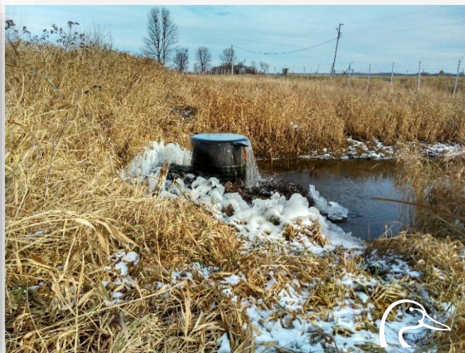
Évacuation du niveau d'eau par le régulateur
