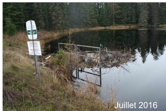
Problématique du castor (structure bloquée)
