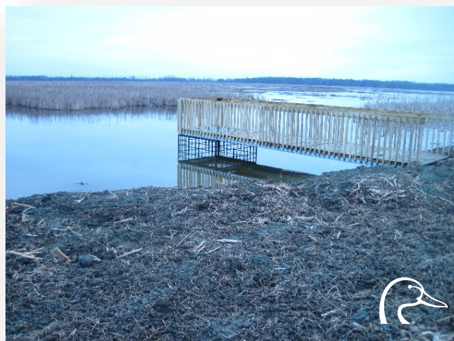
Côté amont de la structure (cage et passerelle d'accès)
