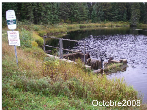
Ouvrages de contrôle du niveau d'eau (structure et digue)
