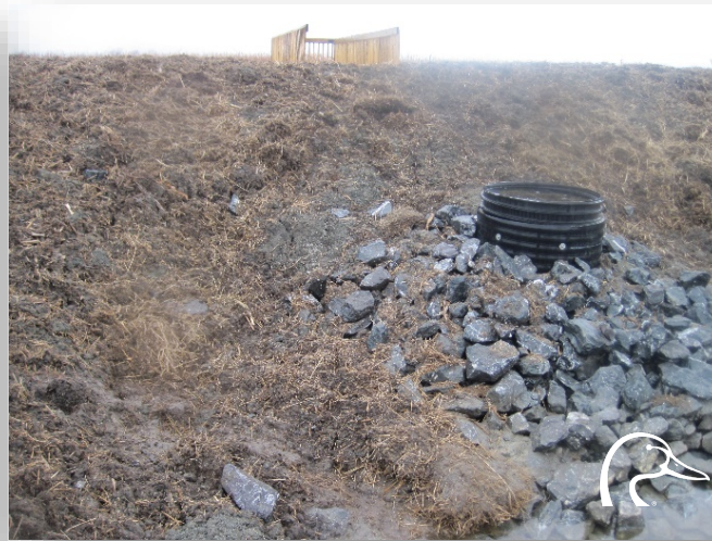
Côté aval de la structure (tuyau de sortie (régulateur) enroché)
