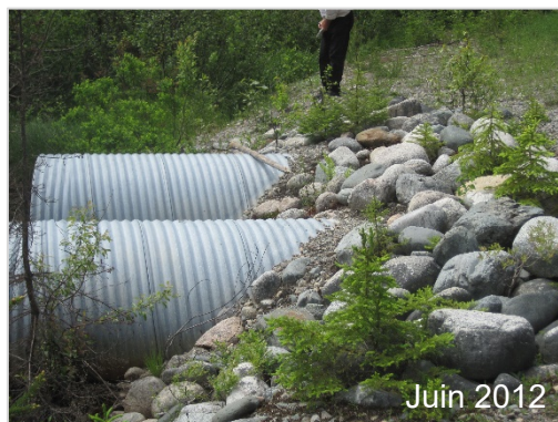
Conduites d'évacuation (tuyaux TTOG)
