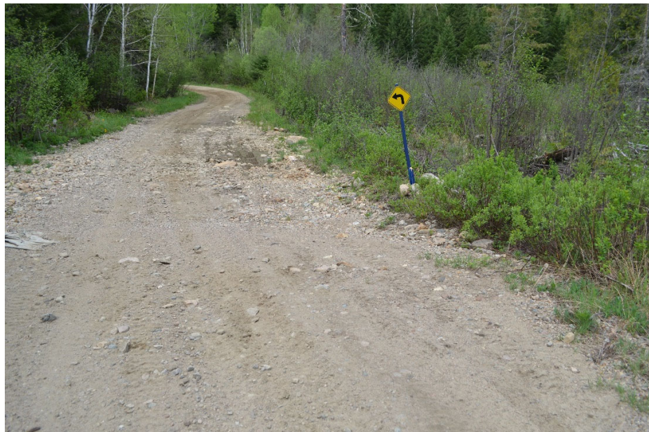
Figure 3. Traces d'érosion sur le chemin découlant du débordement du ponceau
