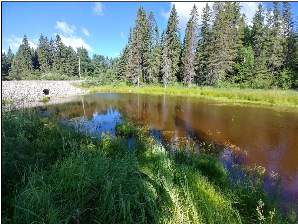
Photo 4 : Vue de la station RW-1, côté aval
