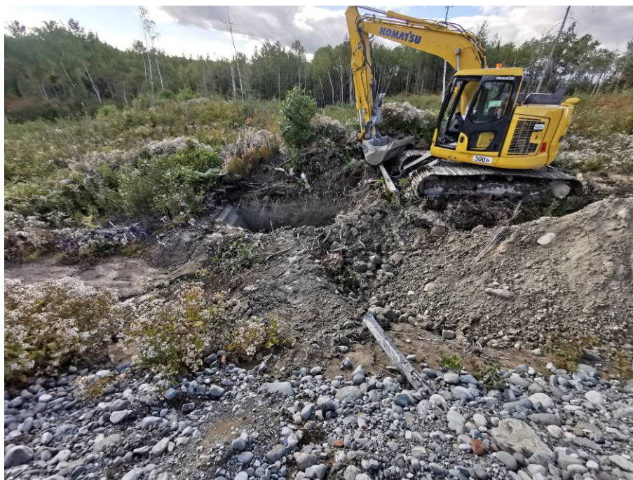
Photo 10 Tranchée 20TR-EF-7150 et pelle mécanique utilisée pour les travaux de septembre (10 septembre 2020)
