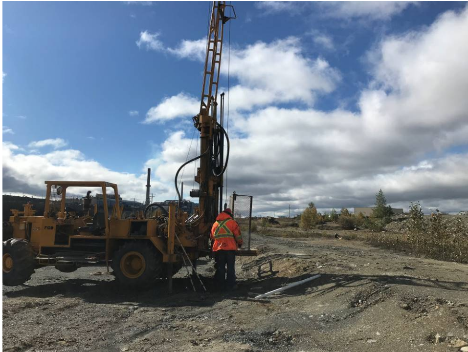
Photo 7 Équipement utilisé pour l'aménagement des puits. Vue du puits PO-19-01 (1 octobre 2019).
