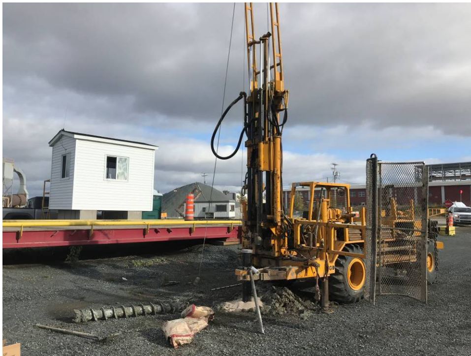
Photo 8 Puits PO-19-02 (2 octobre 2019).
