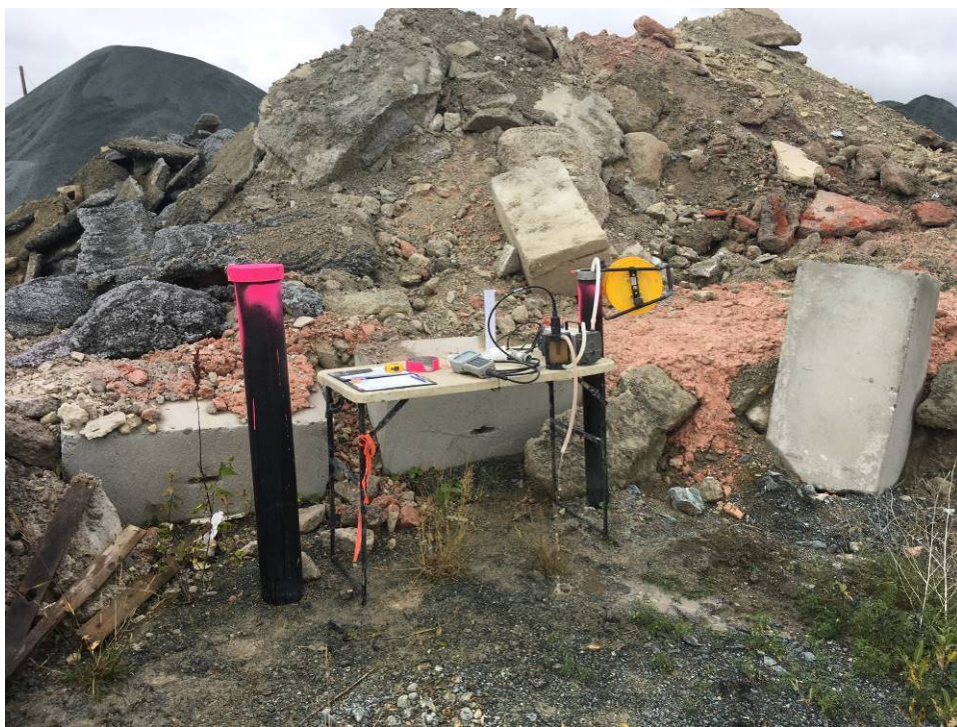
Photo 12 Équipement et installation pour échantillonnage de l'eau souterraine, puits MW-16-18BF (4 octobre 2019).
