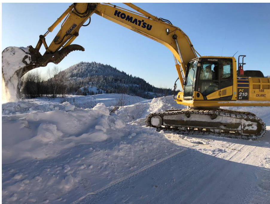
Photo 2 Pelle mécanique utilisée lors des travaux de décembre 2019.
