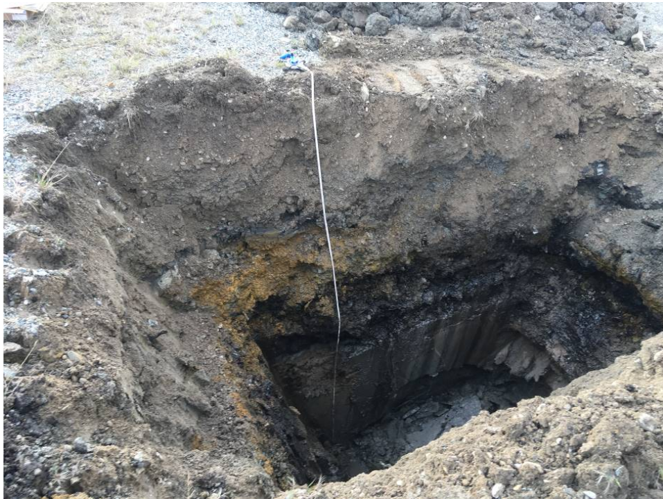
Photo 3 Tranchée TR-19-35 (29 mai 2019).
