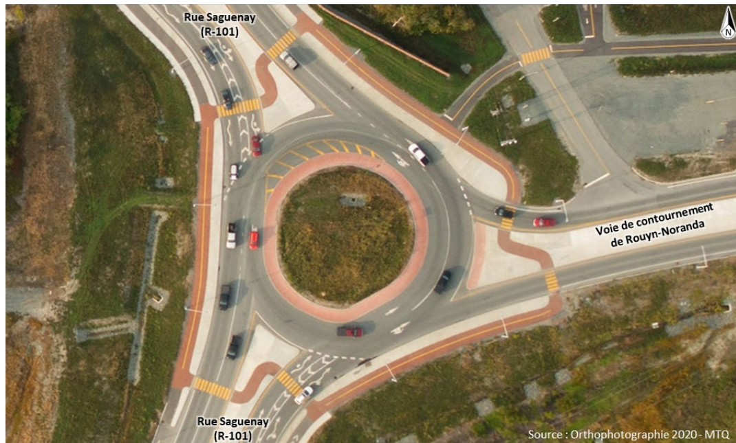
Figure 2.1 Photo aérienne (2020) du giratoire rue Saguenay (R-101)/voie de contournement
