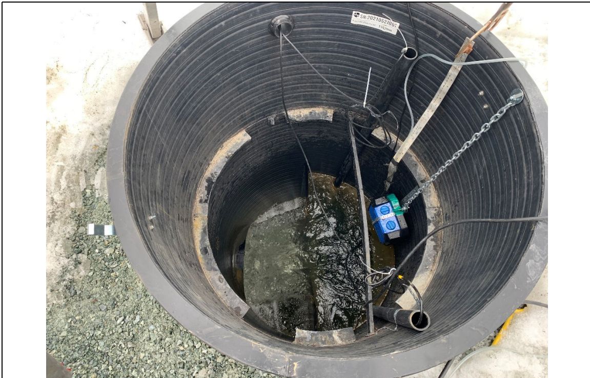
Photo 1 : Vue du déversoir
