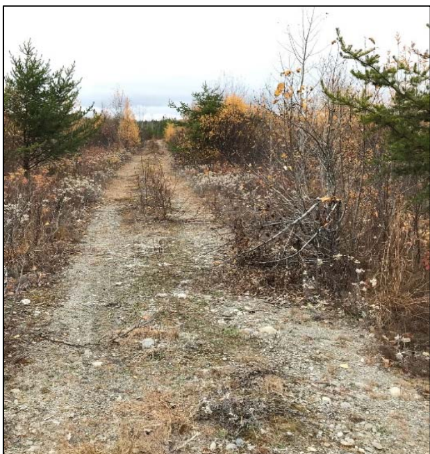
Photo 7 Chemin E-124, fin de fourche, partiellement refermé
