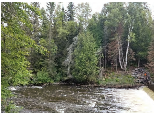
Photo 4. Enrochement en rive droite en aval du barrage (2022)
