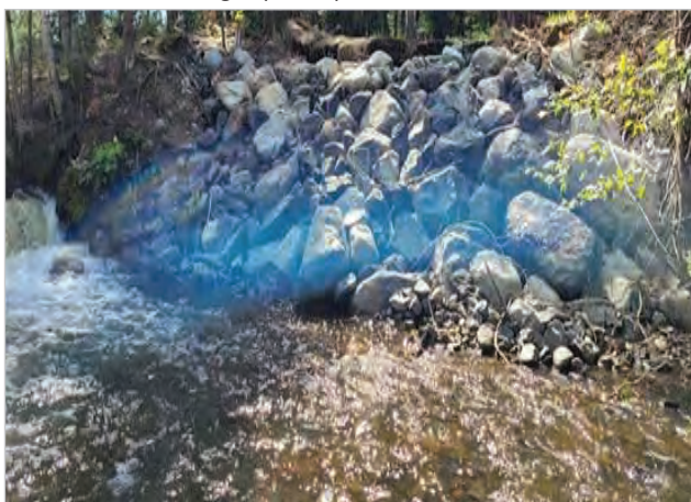
Photo 5. Vue rapprochée sur l'enrochement en rive gauche (2021)
