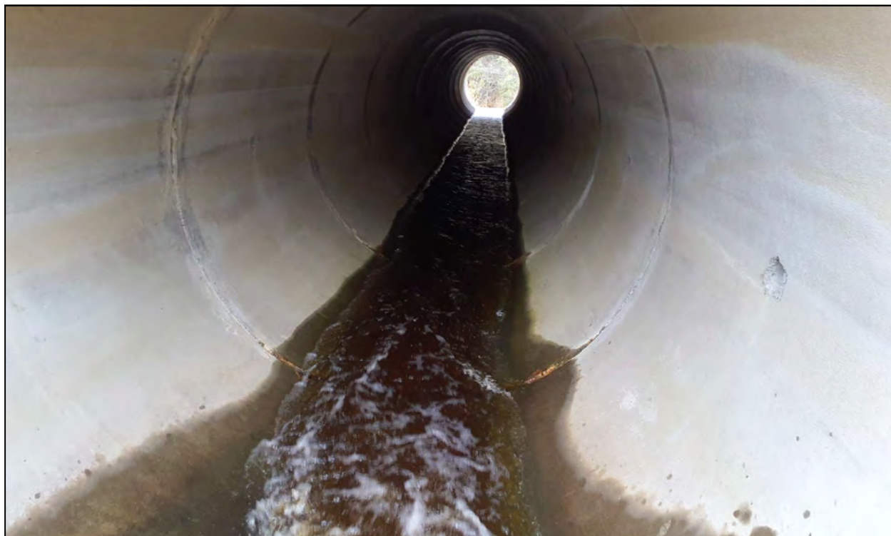
Photo 28. Ruisseau Paré — Segment 1 — Ponceau sous la route 111
