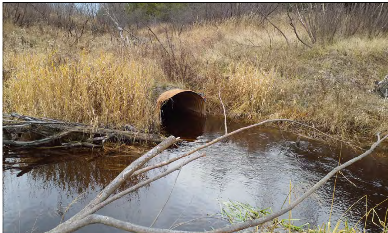
Photo 27. Ruisseau Sans nom 3 — Segment 1 — Ponceau en tôle ondulé
