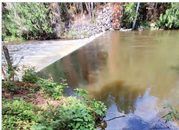
Photo 3. Enrochement en rive droite en aval du barrage (2021)
