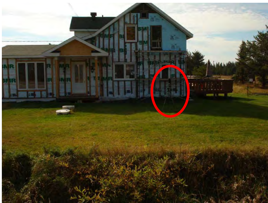
Installation du sonomètre au point P5
