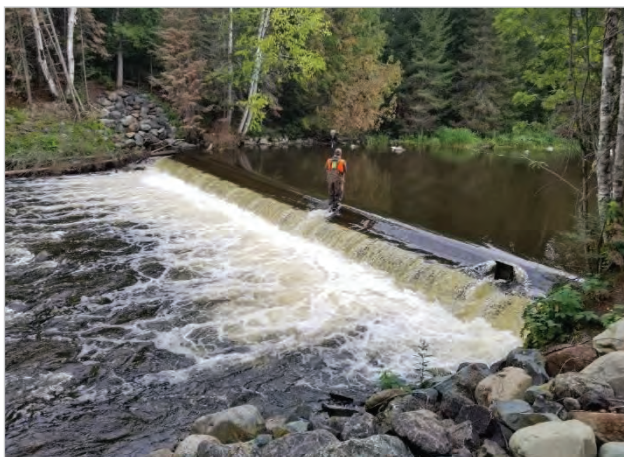
Photo 2. Aspect du barrage le 25 août 2022
