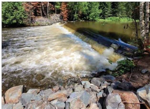
Photo 1. Aspect du barrage le 31 août 2021
