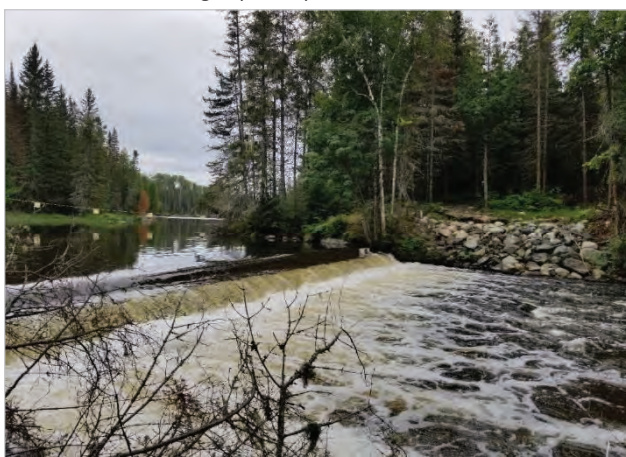
Photo 6. Enrochement en rive gauche en aval du barrage (2022)
