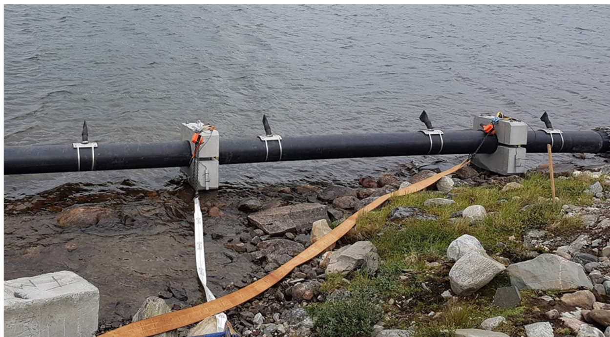
Figure 2-1 Exemple d'un Diffuseur avec Valve (Phase d'Installation)
