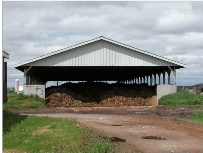
Figure 2 - Exemple de structure d'entreposage des boues solides 36
