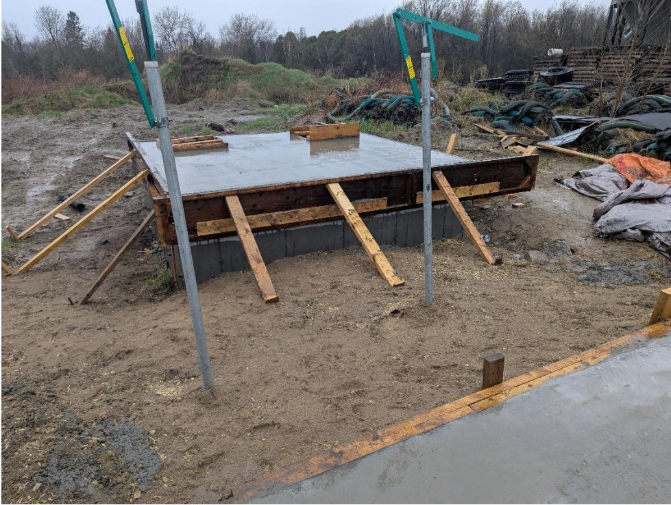
Figures 15 : Nouvelles installations du dalot collecteur
