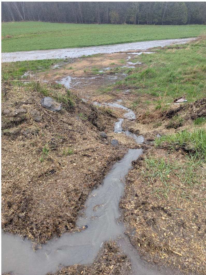
Figures 14 : Écoulements à partir de la dalle de transport vers la tranchée
