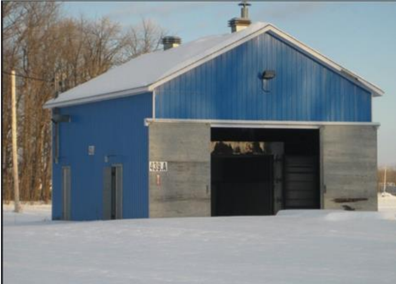
Bâtiment 439, GD-OTS Valleyfield 2025.
