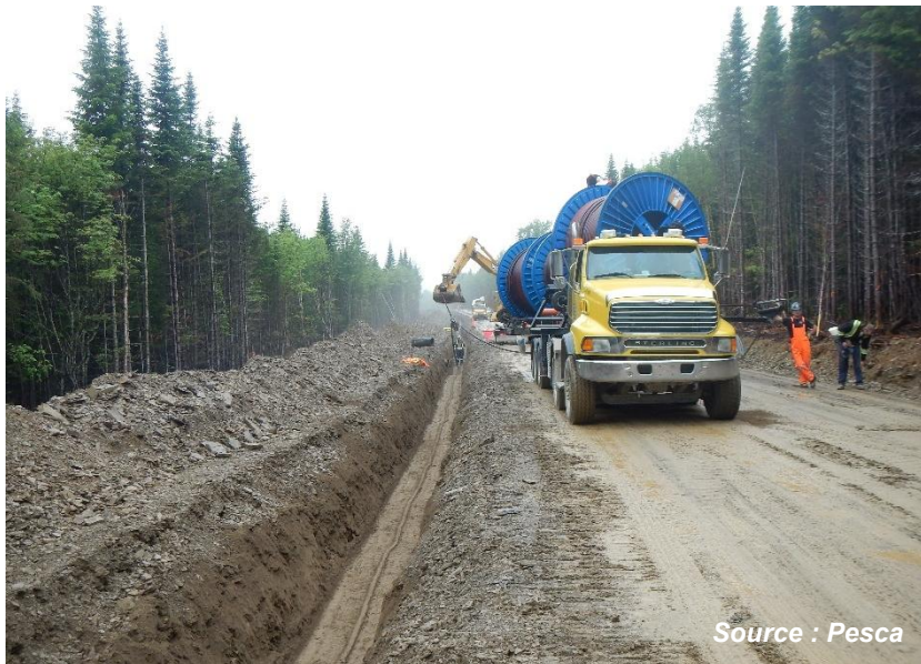
Figure 7. Installation d'un réseau collecteur souterrain
