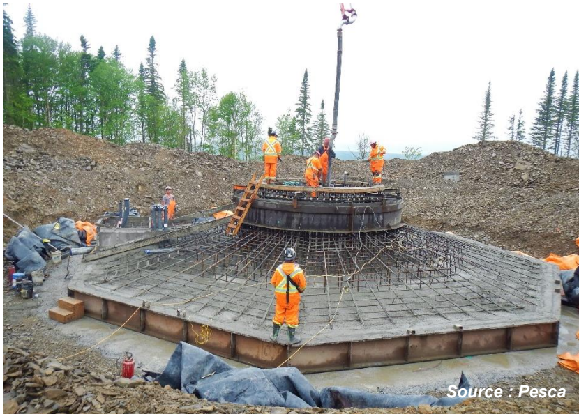
Figure 6. Construction d'une fondation d'éolienne circulaire
