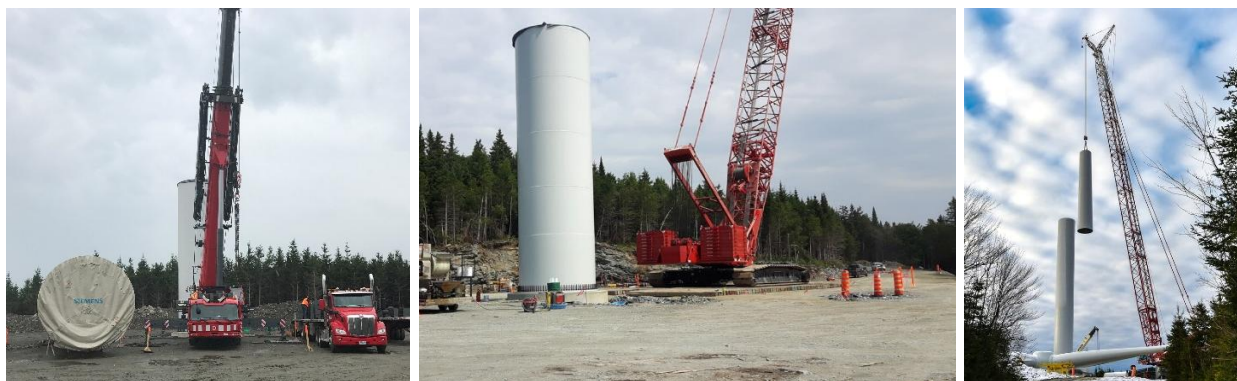
Figure 4-5 – Mise en place d'une éolienne
