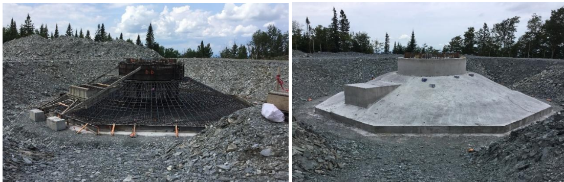
Figure 4-4 – Fondation d'une éolienne (source Pattern)
