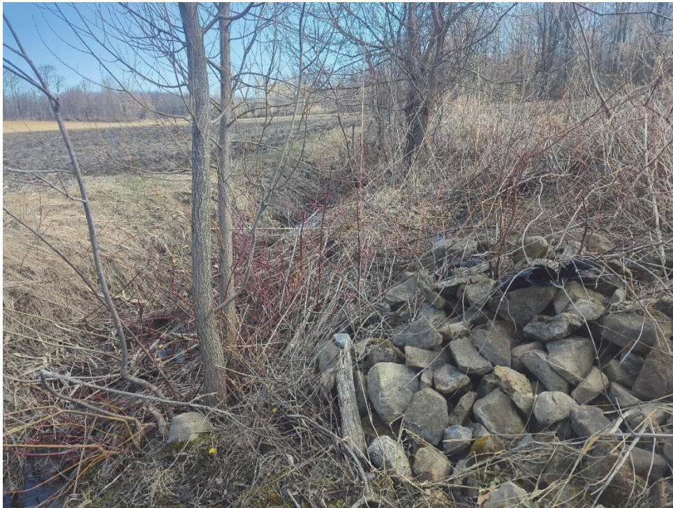
8. Hibernacle confirmé (S-03), poste de transformation, amas rocheux.
