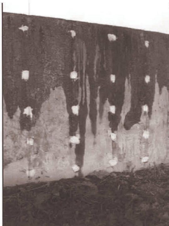
Figure 7 – Tirants de coffrage extérieurs hors-sol scellés 08-08-2019
