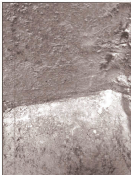
Figure 5 – Joint entre le mur et la semelle de fondation
