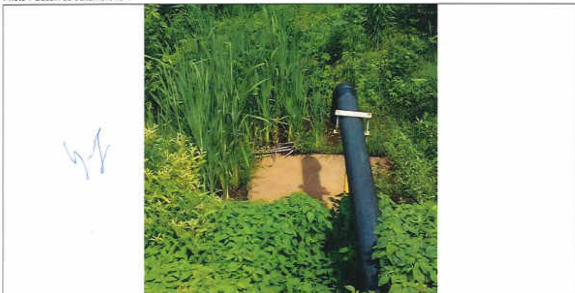
IMG_20190709_114256 (1024x1024).jpg Photo 8 Effluent final après traitement. Pose d'une dalle de béton dans le fond du fossé.
