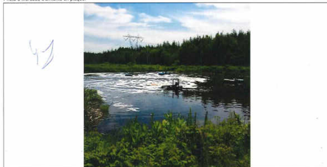
Photo 6 Bassin de traitement no 4 avec aérateur
