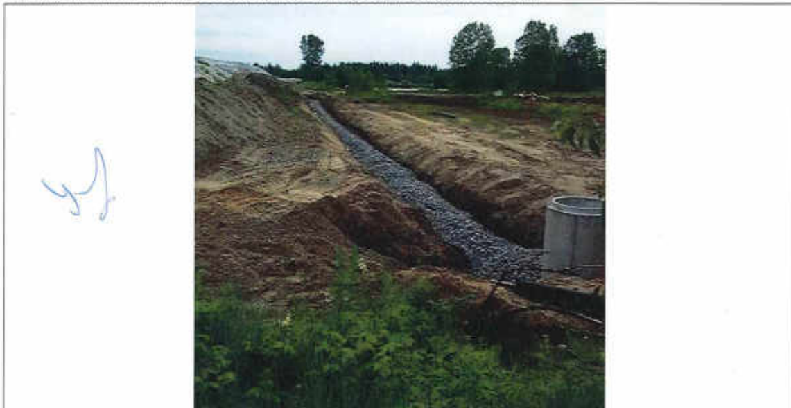
Photo 2 Drain supplémentaire installée au bout de la cellule.
