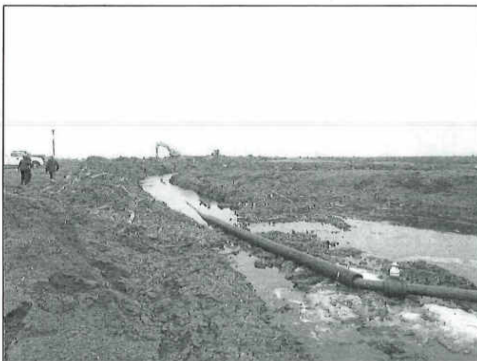
PHOTOGRAPHIE 3 - TRANSFERT DE L'EAU DE LA CONDUITE DE 100mm À LA CONDUITE PERFORÉE DE 150mm 26 NOVEMBRE 2014
