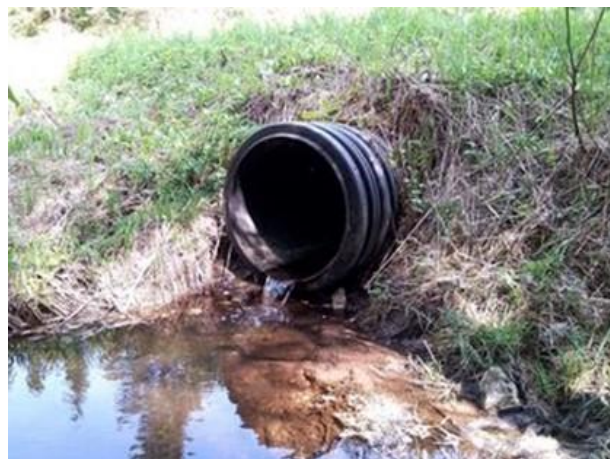
Photo 6. Ponceau simple en plastique, CE2 (SH001)
