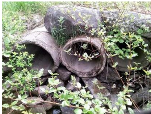
Photo 16. CE11, ponceau triple en béton (SH016)
