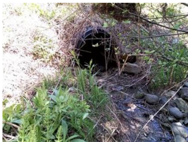
Photo 10. CE6, ponceau simple en plastique (SH041)
