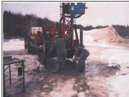
Photo 4 : Installation du puits d'observation PQ-102.
