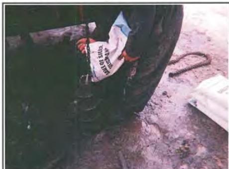
Photo 2 : Installation du puits d'observation PO-101.
