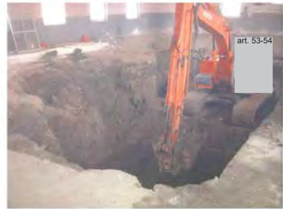
Photo 12 : 25-10-2007 Excavation des sols contaminés dans le secteur de l'appareil de levage hydraulique. On remarque que les excavations EX-1 et EX-2 se sont rejointes. Vue vers le nord.
