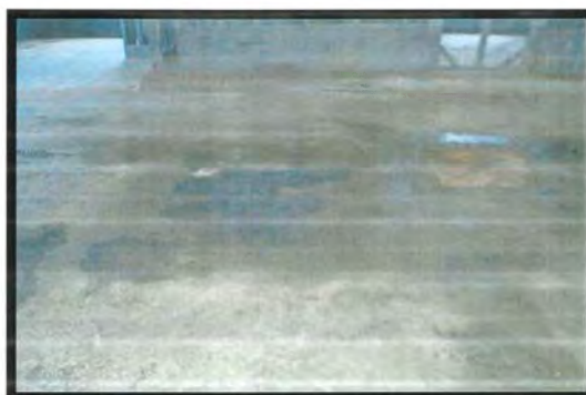
PHOTOGRAPHIE # 22: Vue rapprochée de la surface de la dalle tachée de produits pétroliers dans l'ancien garage.
