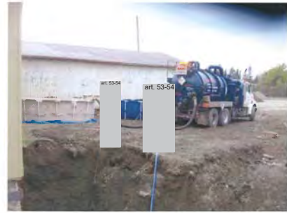
Photo 11 : 19-10-2007 Pompage et disposition à l'aide d'un camion-vacuum de l'eau contaminée entreposée temporairement. Vue vers l'ouest.
