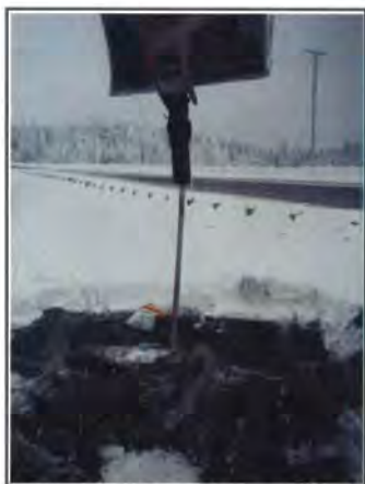
PHOTO 4 : Démantèlement du puits d'observation PO-4.
