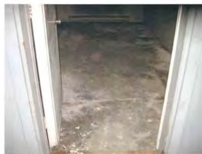
Photo 4 : 11-10-2007 Taches d'hydrocarbures sur la dalle de béton du plancher. Vue vers l'est.
