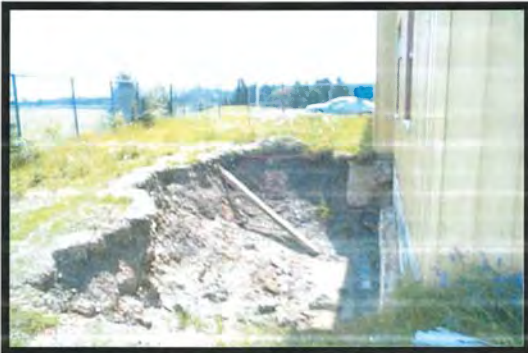
PHOTOGRAPHIE # 12: Tranchée d'un ancien réservoir souterrain d'huile à chauffage enlevé. Nord-est du bâtiment. Vue vers le sud-est.
