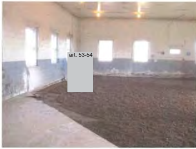
Photo 17 : 30-10-2007 Remblai final des excavations EX-1 et EX-3 avec de la pierre concassée. Vue vers le nord.
