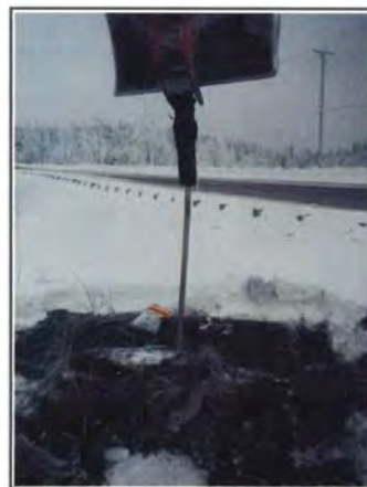
PHOTO 4 : Démantèlement du puits d'observation PO-4.
