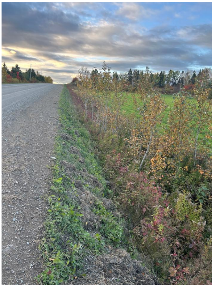
Absence d'un lit d'écoulement (fossé)
