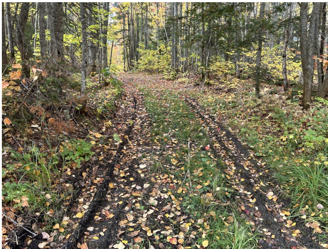
Absence d'un lit d'écoulement
