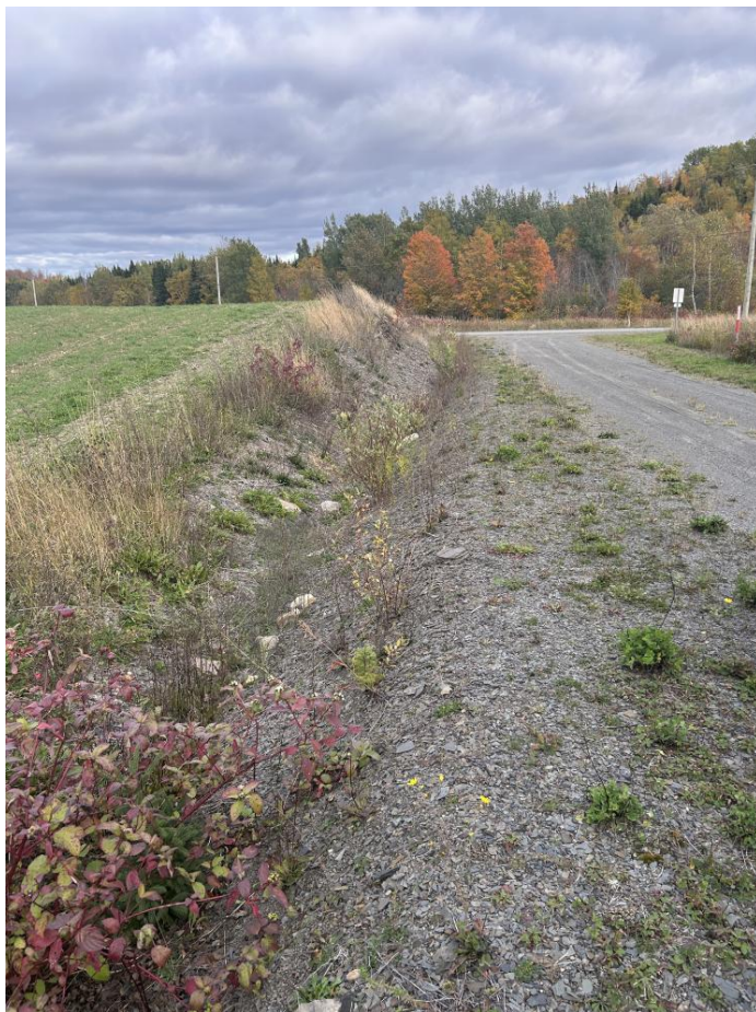
Présence d'un lit d'écoulement
