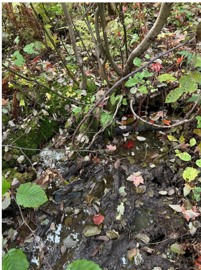
Présence d'un lit d'écoulement
