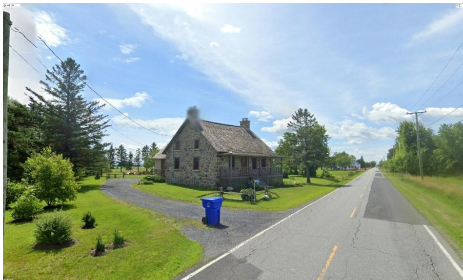
Figure 4 Lot 1 714 268, résidence ancienne (Google Earth, 2024)
