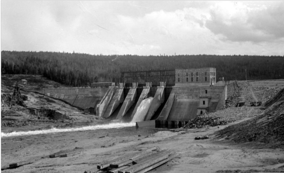
Photo 3. Vue vers l'amont du barrage Matawin depuis la rive gauche (1932)
