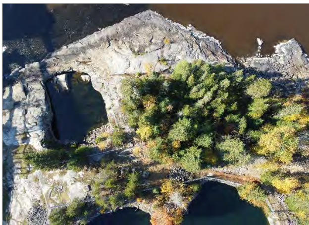
Photo 37. Bassin 2 vu du ciel, notons le bassin 1 en marge inférieure de la photo
