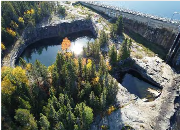
Photo 3. Aspect général des bassins anthropiques B1 et B2 en rive droite (octobre 2024)
