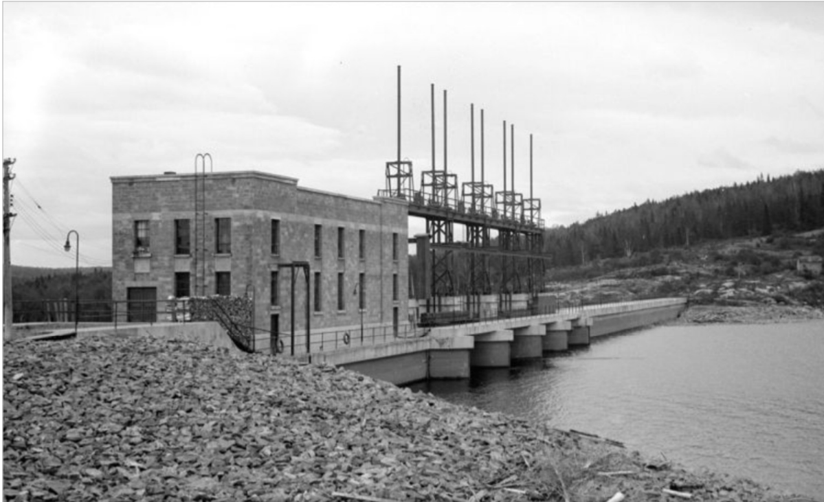
Photo 5. Vue du barrage Matawin en amont depuis la rive gauche (1935)
