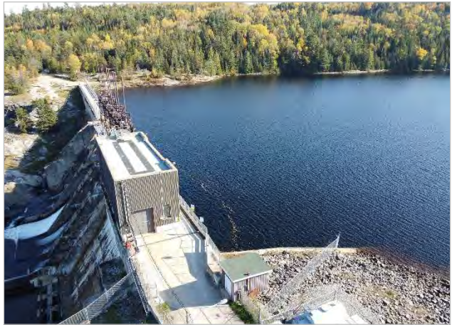
Photo 2. Aspect général de la partie sud-ouest de la zone d'étude et de l'amont du barrage (octobre 2024)
