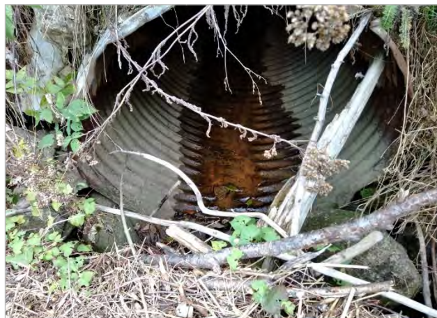
Photo 26. Aspect du ponceau au niveau de l'obstacle OMP1
