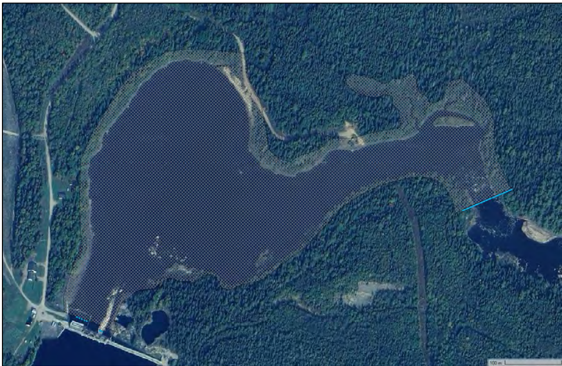
Figure 1 Étendue du domaine modélisé de l'état initial (photo Google Satellite)
