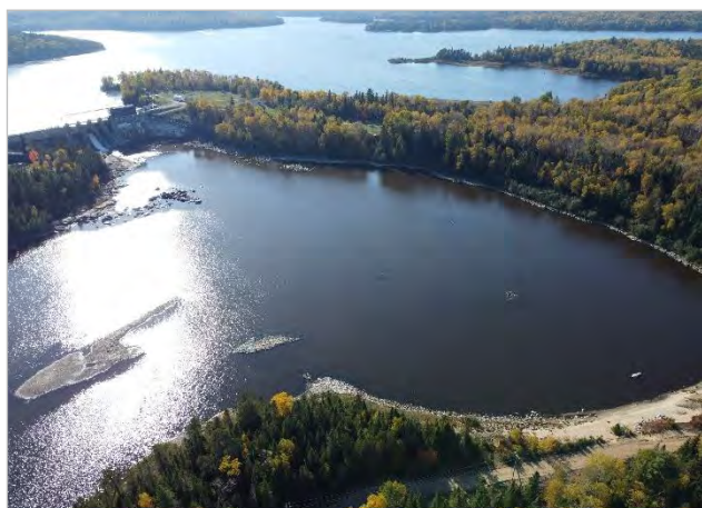
Photo 5. Vue d'ensemble du segment SH2, depuis l'aval
