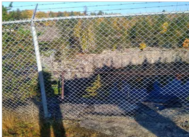
Photo 32. Vue du bassin 1
