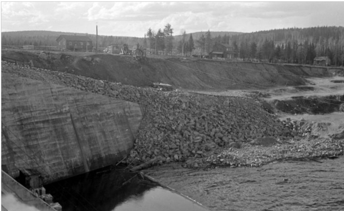
Photo 4. Empierrement en rive gauche du barrage Matawin (1932)
