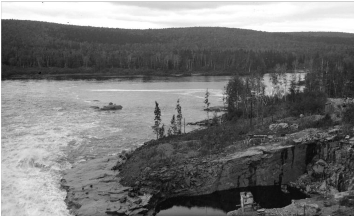
Photo 6. Vue vers l'aval en rive droite depuis le barrage Matawin (1935)
