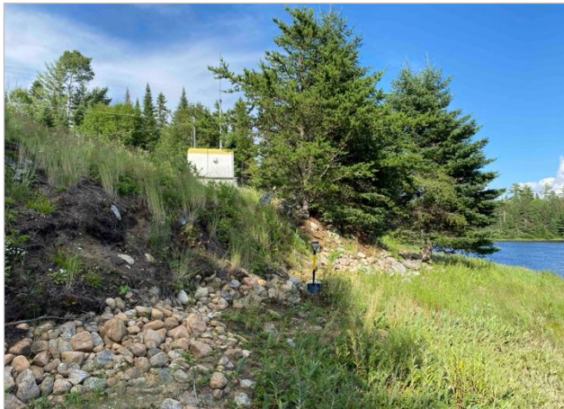
Photo 7. Érosion de faible intensité du talus en rive gauche vers le PK 82,4
