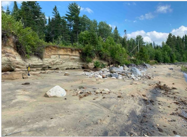
Photo 5. Érosion d'intensité modérée du talus en rive gauche (PK 82,6)
