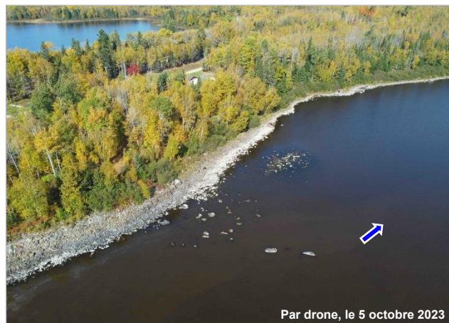
Photo 1. Matériaux grossiers en rive gauche dans le bassin près du barrage (PK ± 82,7)
