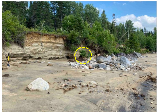
Photo 10. Éboulement mineur en rive gauche
