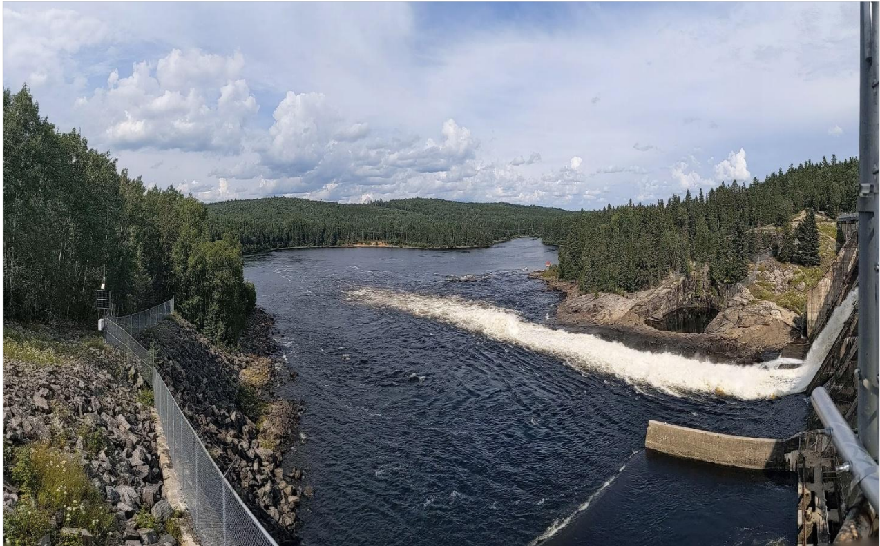
Photo 17. Vue du barrage en rive gauche – Paysage de rivière R1 (PV7)
