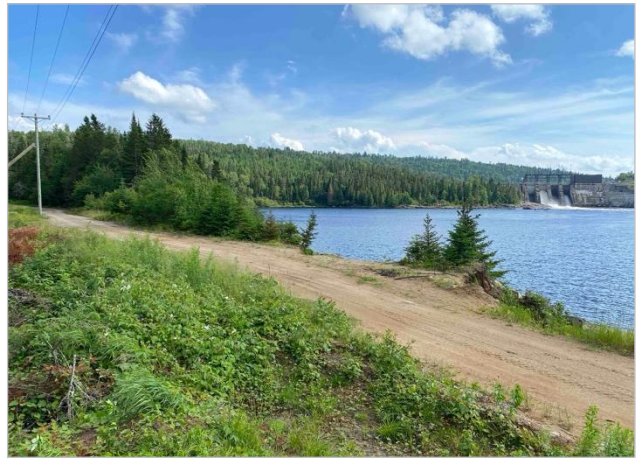
Photo 6. Chemin menacé par l'érosion en rive gauche (PK 82,6)
