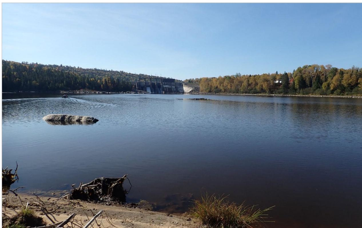
Photo 14. Vue du bassin – Paysage de rivière R1 (PV4)
